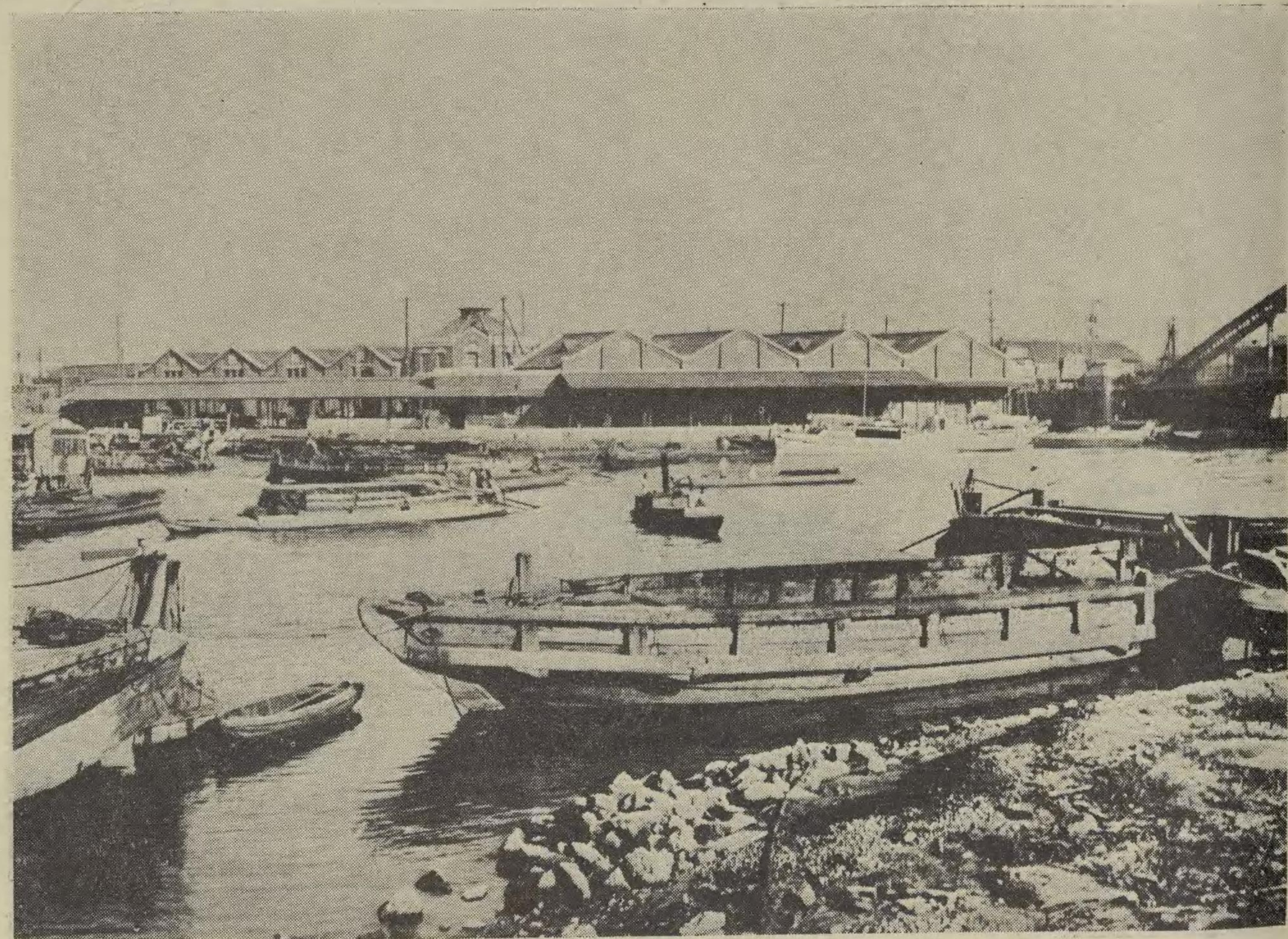
大 阪 支 店 大 正 橋 倉 庫
