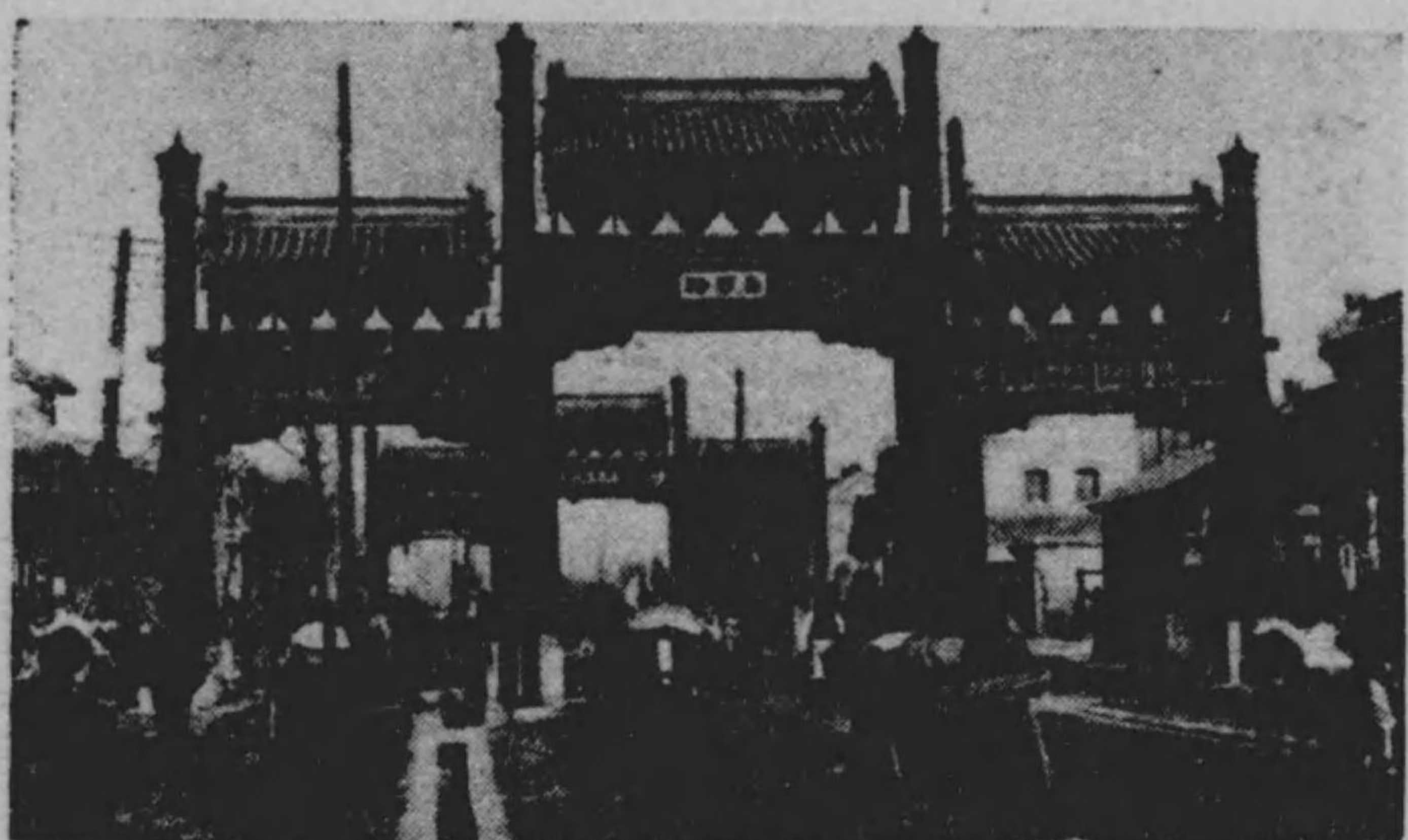
北平城内の殿盛を誇る東四牌路
