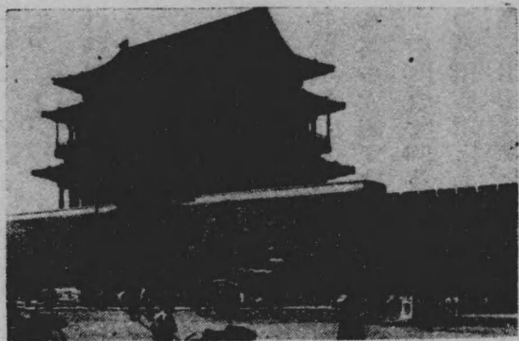
北平支間を飾る正陽門の壯觀と城壁の一部
