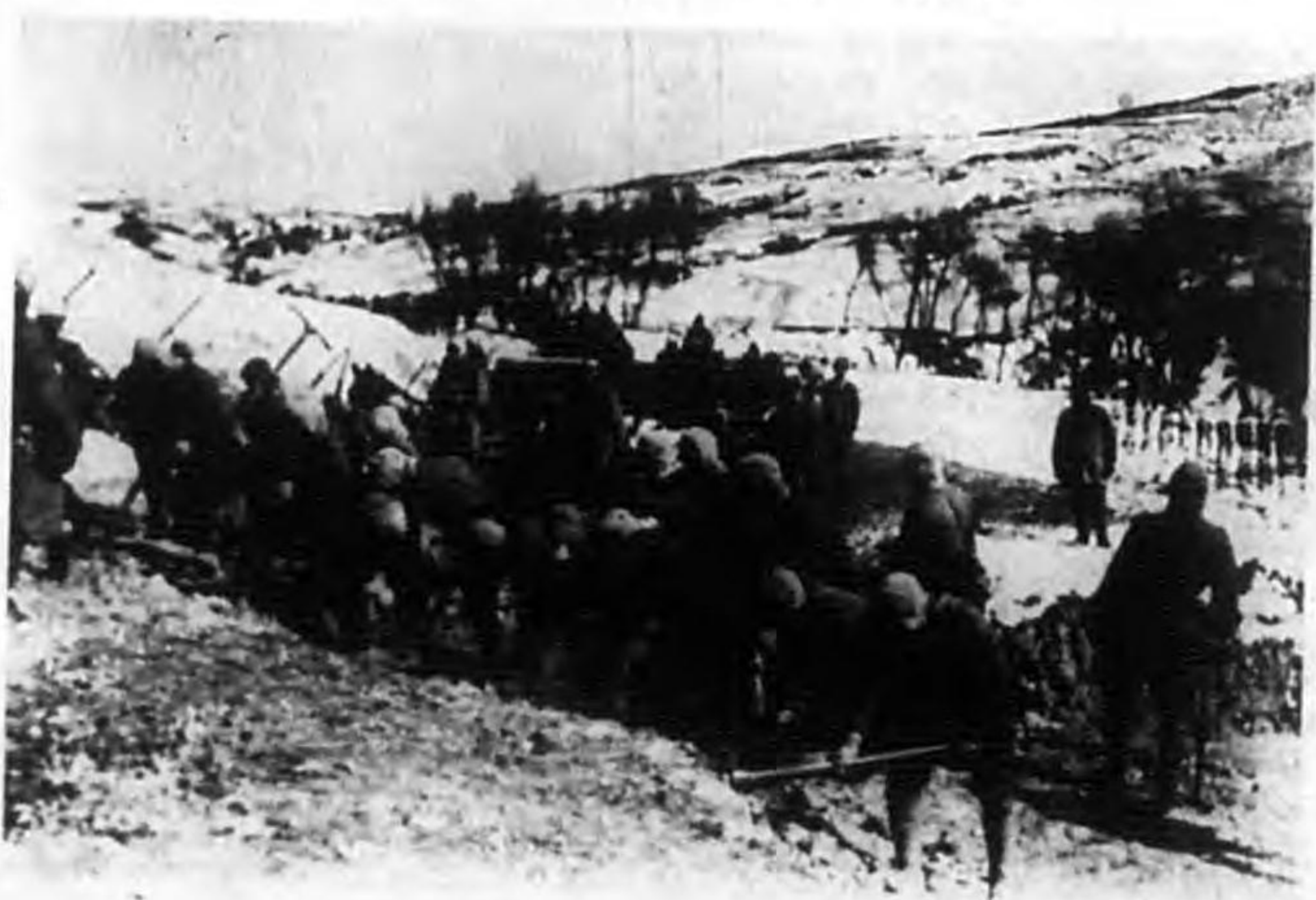
工兵隊ノ道路作業
