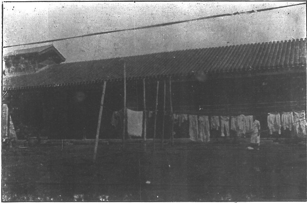
炊 場 及 洗 濯 場 正 面
