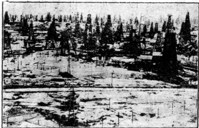
巴庫油田的新建設
