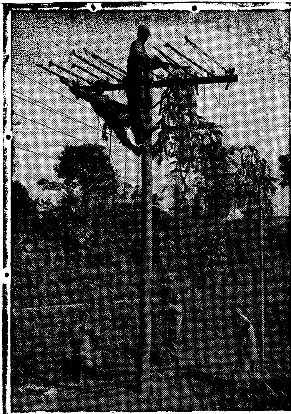
路基築成 之後，翻過 了高山，跨 過了急流， 美陸軍工兵 馬上裝置電 話線。
