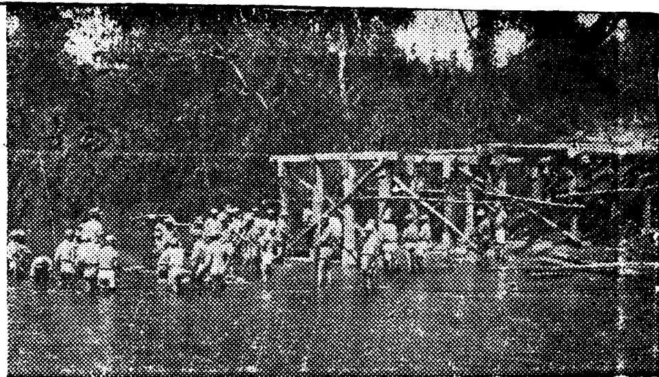
中國工程師和工兵合力建築橋樑 的一個偉大場面。
