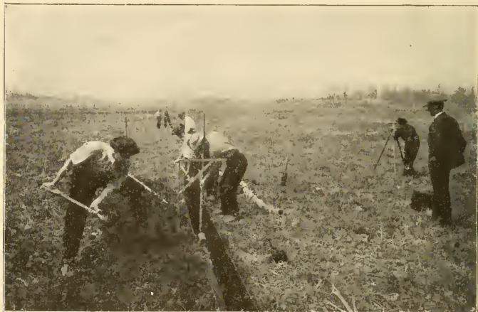
FIG. 48. LAYING TILE
