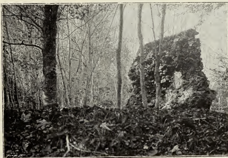
Fig. 105. Padrt. Reste des Mauerwerkes an der Nordostseite (Ansicht von der Südseite).
