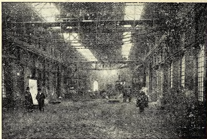
Un Pont roulant à courant triphasé fonctionne dans la galerie des machines
