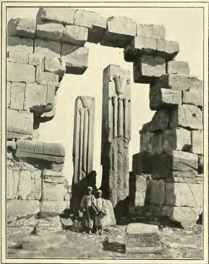
TULIP COLUMNS AT KARNAK.
