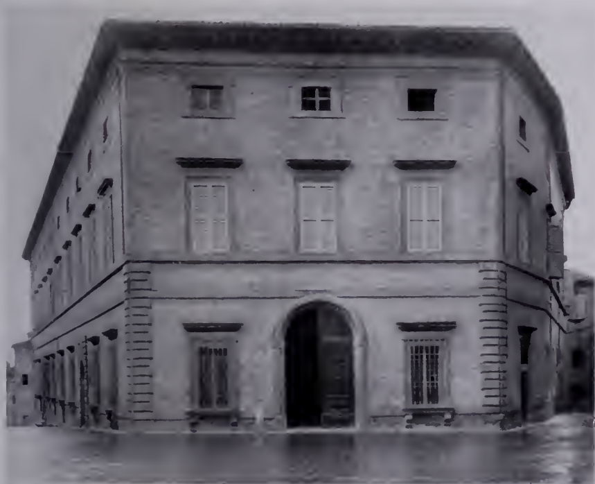
Fig. 655 - Macerata. Palazzo Razzanti, poi Ciccolini. Pellegrino Tibaldi: Facciata. (Fot. Ceccato).
