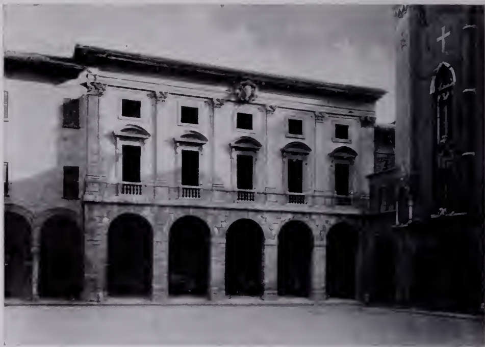
Fig. 830 — Bologna, Palazzo Salem. Domenico Tibaldi: Facciata. (Fot. Ceccato).
