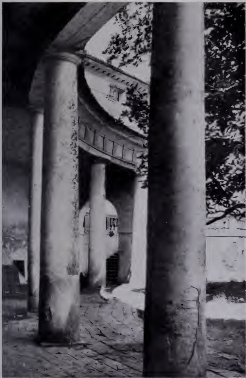
Fig. 431 — Fratta Polesine, Villa Badoer. Palladio: Particolare dei colonnati. (Dal Lukomski).
