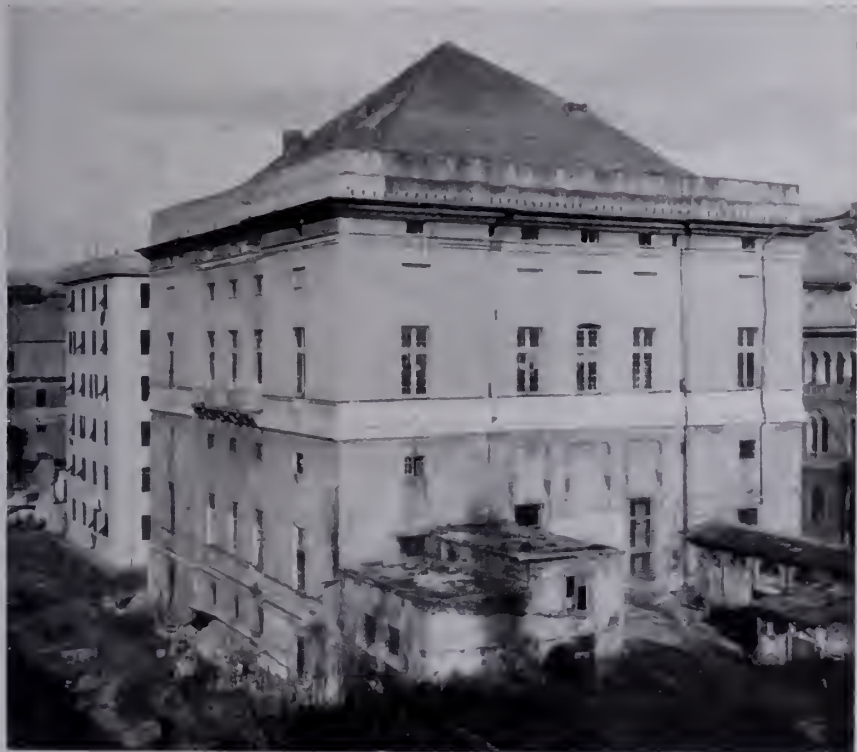
Fig. 636 — Genova, Palazzo detto della Fortezza a Sampierdarena. Bernardo Spazio, aiuto di Galeazzo Alessi: Facciata. (Per cortesia del Municipio di Genova).
