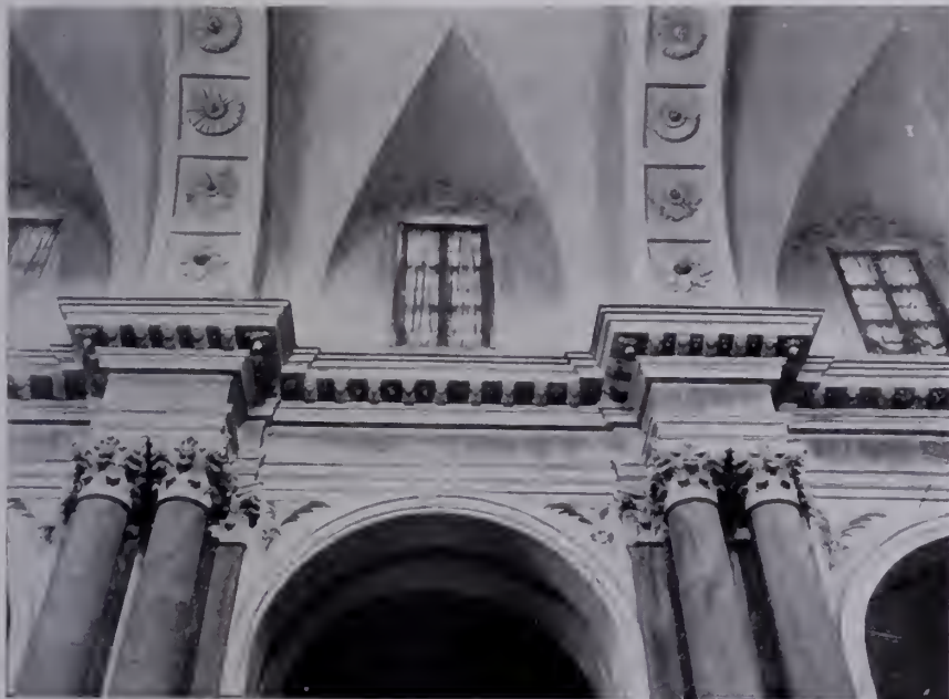
Fig. 700 — Vercelli, Sant'Eusebio. Pellegrino Tibaldi: Arcate, fasci di colonne, trabeazione. (Fot. Ceceato).
