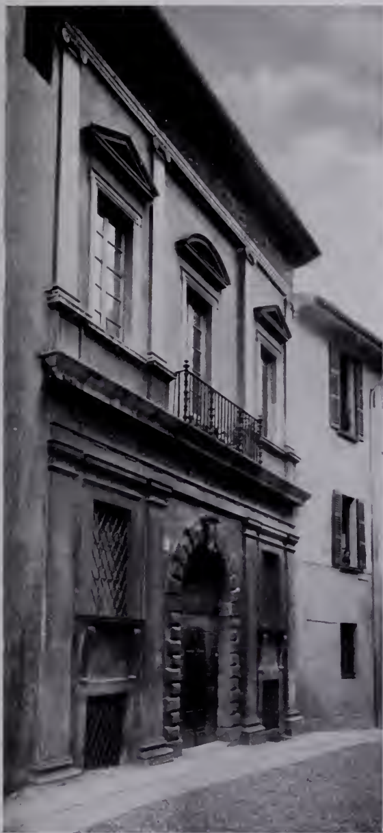
Fig. 498 — Brescia, Palazzina Lana-Ghidella, in via Agostino Gallo, Ludovico Beretta (?): Facciata. (Fot. Rinaldo Schreiber, Brescia).
