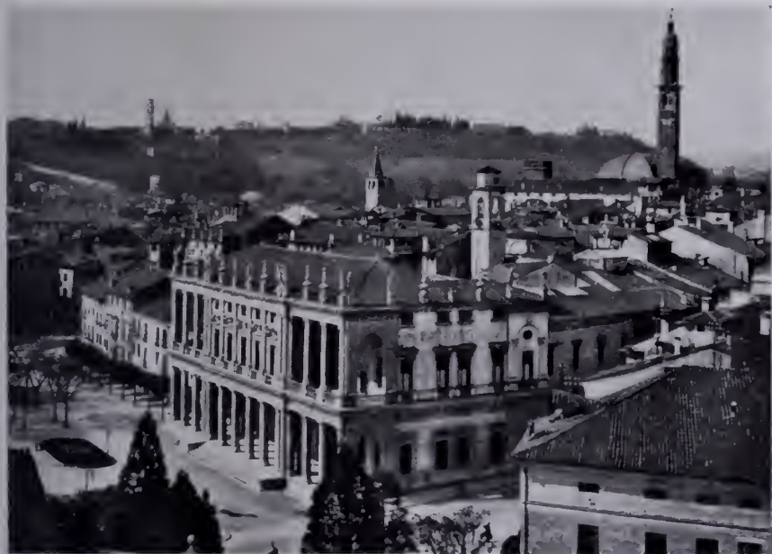
Fig. 305 — Vicenza, Palazzo Chiericati dalla torre dell'Osservatorio. (Fot. Chiovato).
