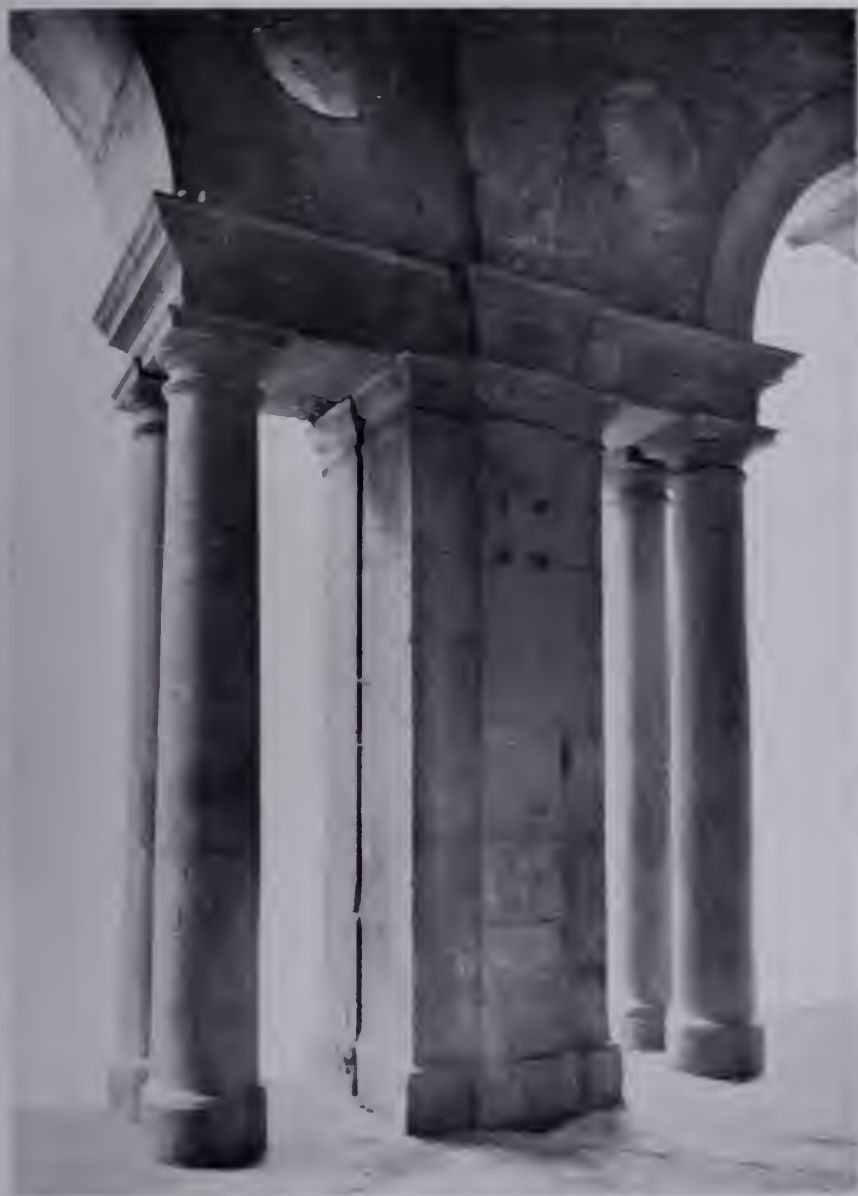
Fig. 299 — Vicenza, Basilica, Palladio: Loggia inferiore, un fascio di pilastri e colonne. (Fot. Ferrini)
