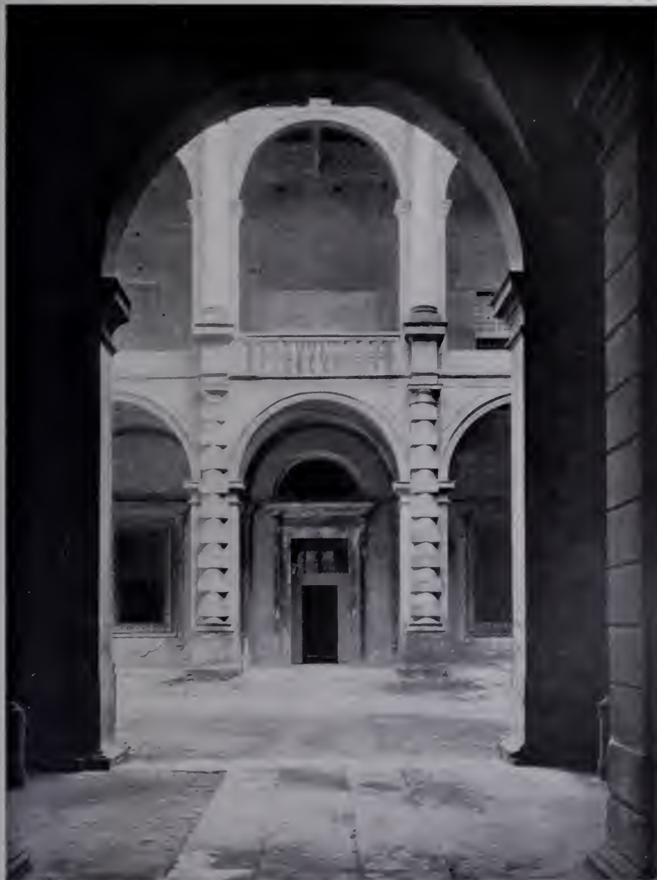
Fig. 825 — Bologna, Palazzo Bentivoglio. Francesco Morandi: Cortile (particolare). (Fot. Alinari).
