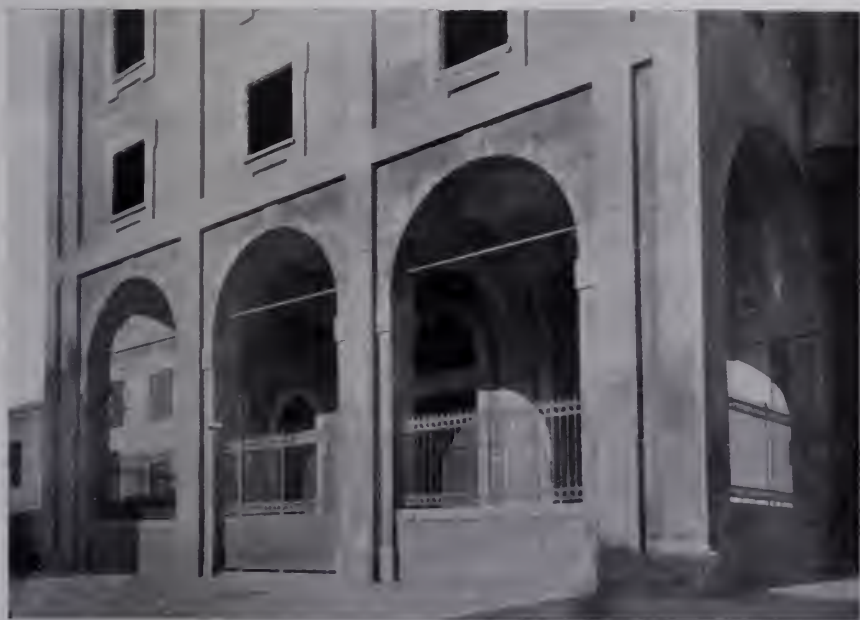
Fig. 844 — Bologna. Portico di San Rocco. Pietro Fiorini: Facciata. (Fot. Enea Croci).
