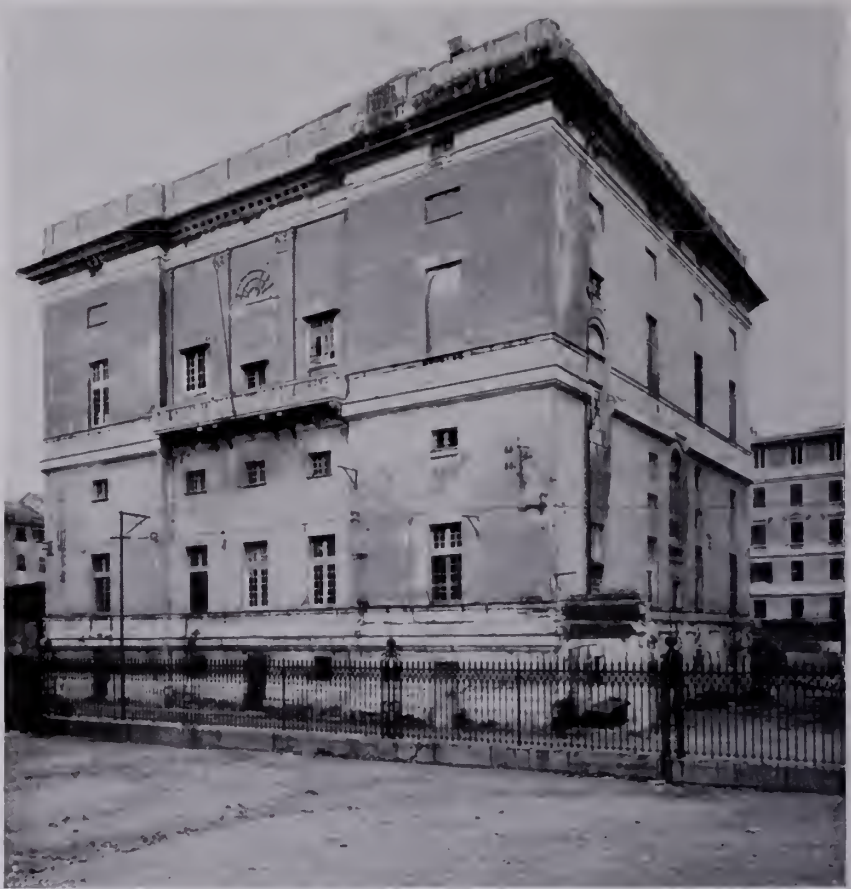
Fig. 637 — Genova, Palazzo detto della Fortezza a Sampierdarena. Bernardo Spazio, aiuto di Galeazzo Alessi: Altra facciata. (Per cortesia del Municipio di Genova).
