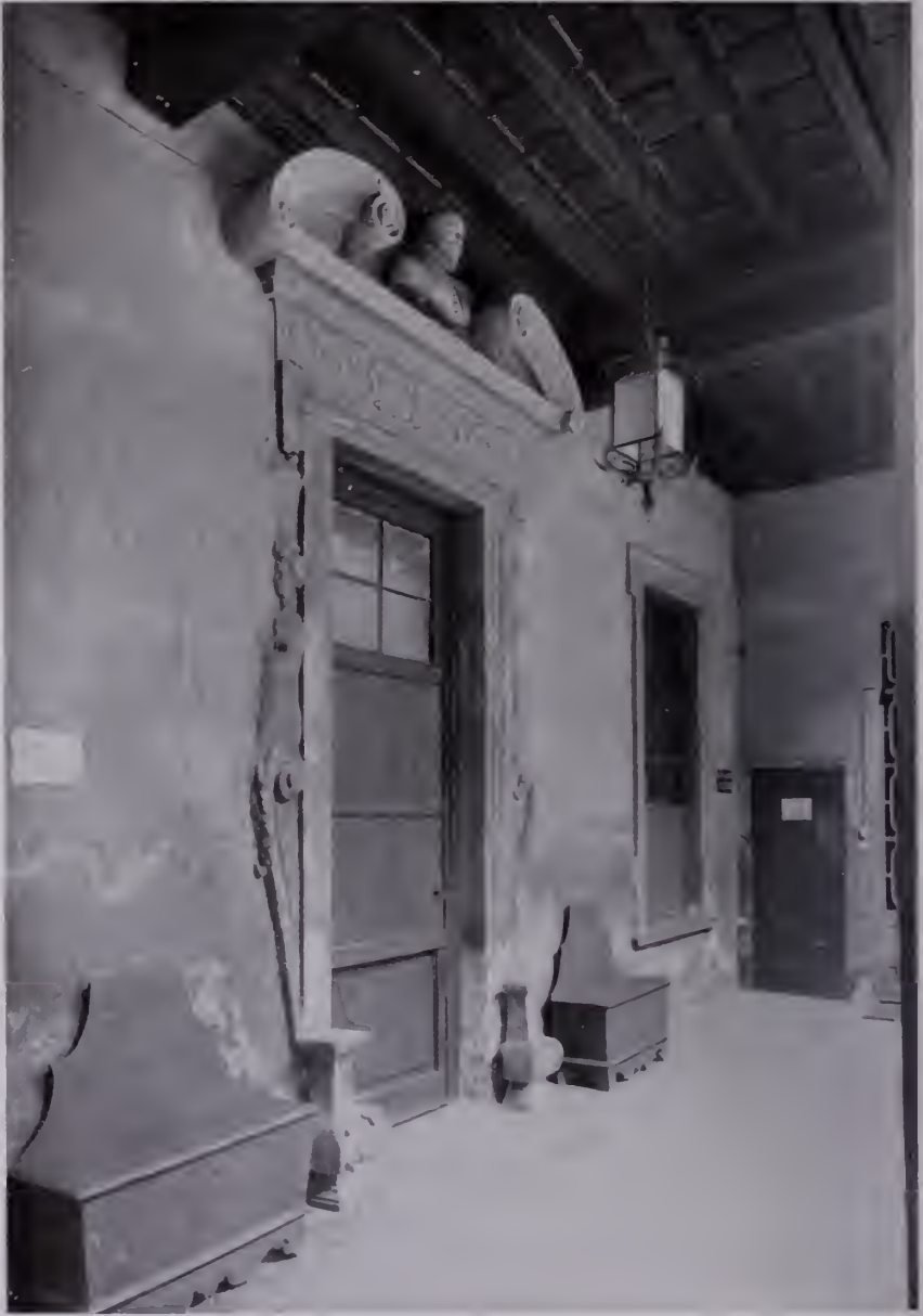
Fig. 722 — Como, Palazzo Natta-Tibaldi: Porta centrale nel secondo sottoportico del cortile.
