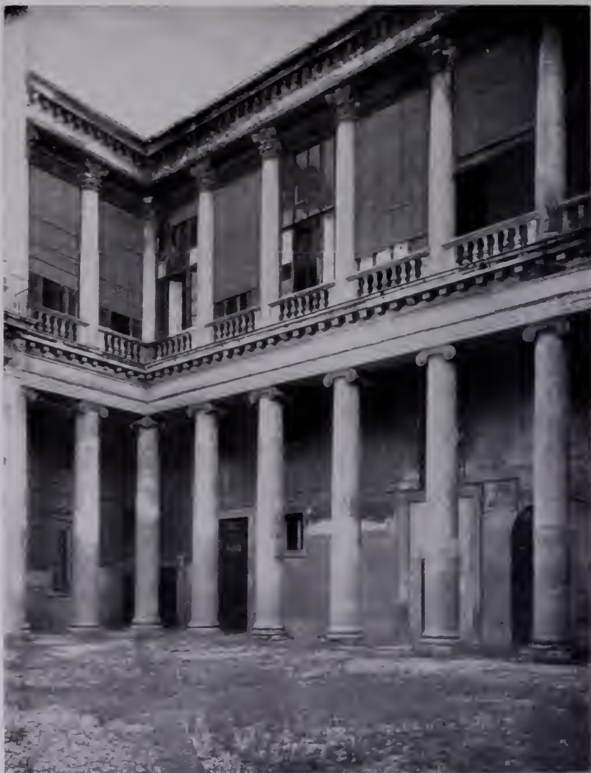
Fig. 405 — Vicenza, Palazzo Porto-Barbaran. Palladio: Loggia nel cortile.
