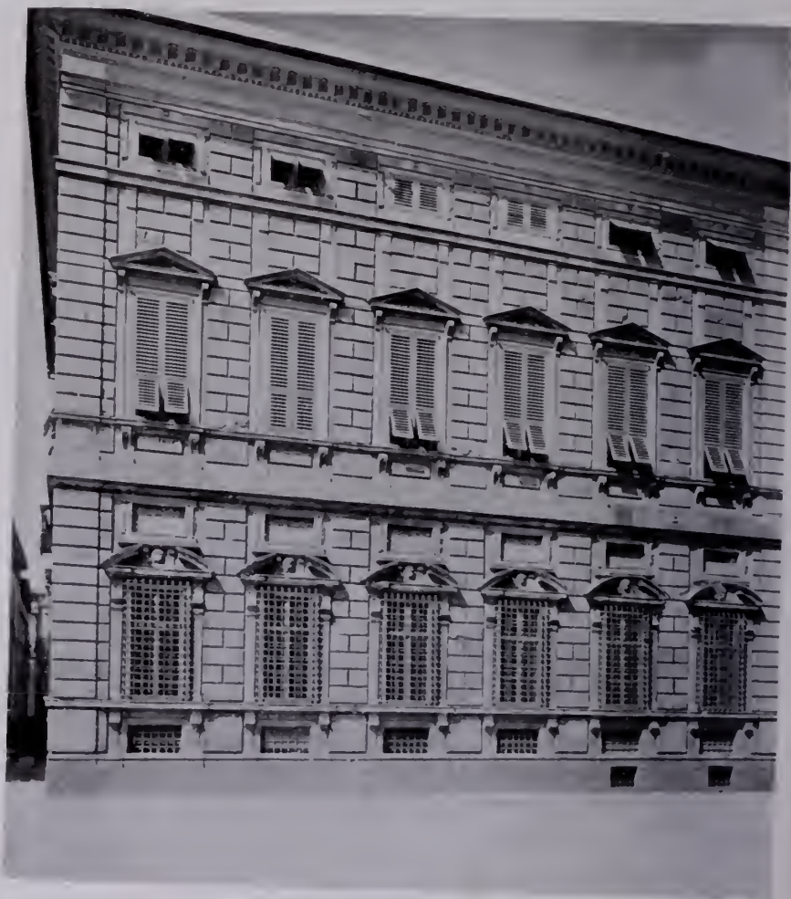
Fig. 555 — Genova Palazzo Cambiaso. Alessi: Facciata verso la piazza Fontane Marose. (Per cortesia del Municipio di Genova).
