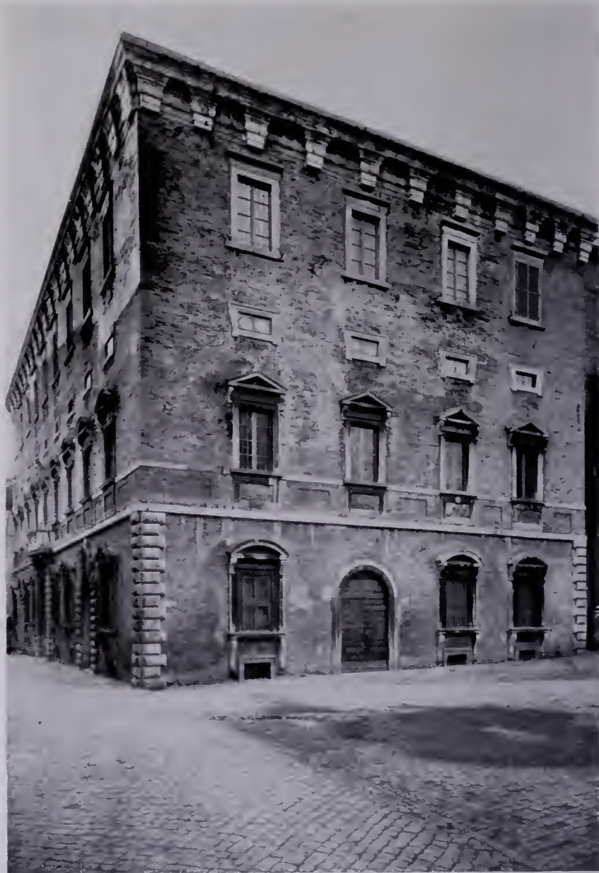
Fig. 660 — Ancona, Palazzo Ferretti. Pellegrino Tibaldi: Facciata (vista di scorcio). (Fot. Ceccato).
