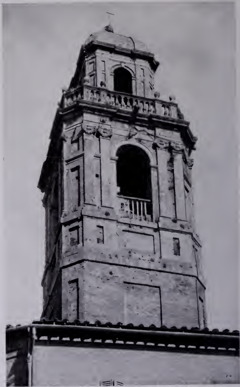
Fig. 607 — Perugia, Santa Maria Nuova. Alessi: Campanile. (Fot. Urbini).
