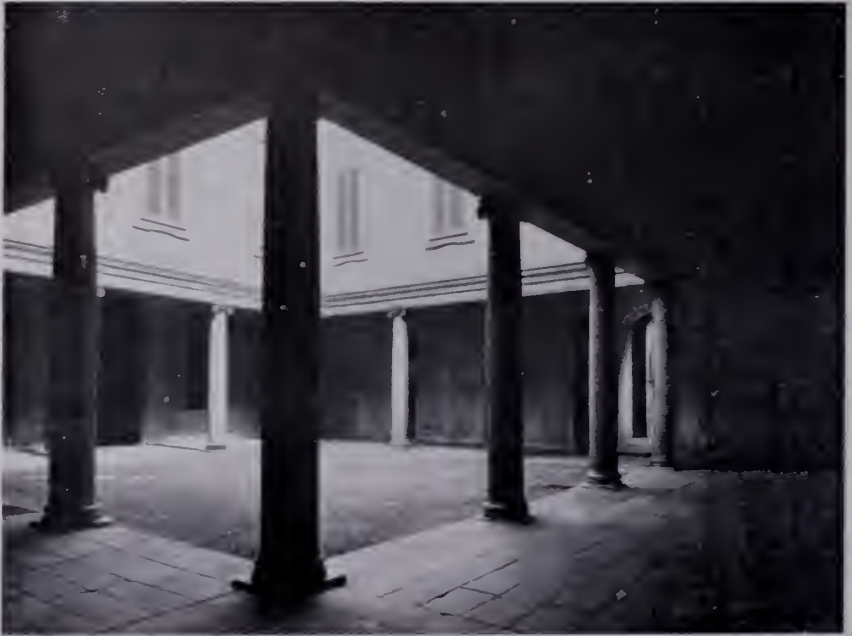
Fig. 757 — Milano, Palazzo in Via Borgonuovo, 14. Maniera tibaldesca: Cortile. (Fot. Ceccato).
