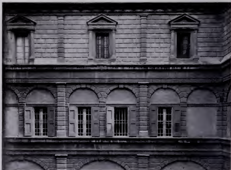
Figg. 809-810 — Bologna, San Giovanni in Monte (oggi Carceri). Antonio Morandi: [Sopra] primo cortile; (sotto) parte superiore del primo cortile [particolari]. (Fot. Enea Croci).
