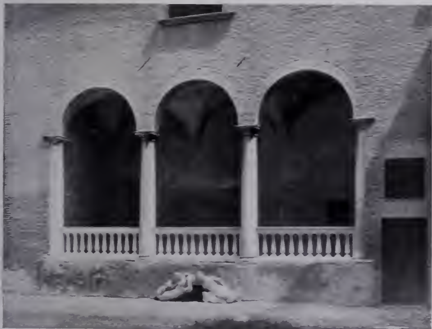
Fig. 855 — Ferrara, Palazzo Strozzi, Alberto Siliatti. Cortile a sinistra dell'entrata. Fot. Cecchi.
