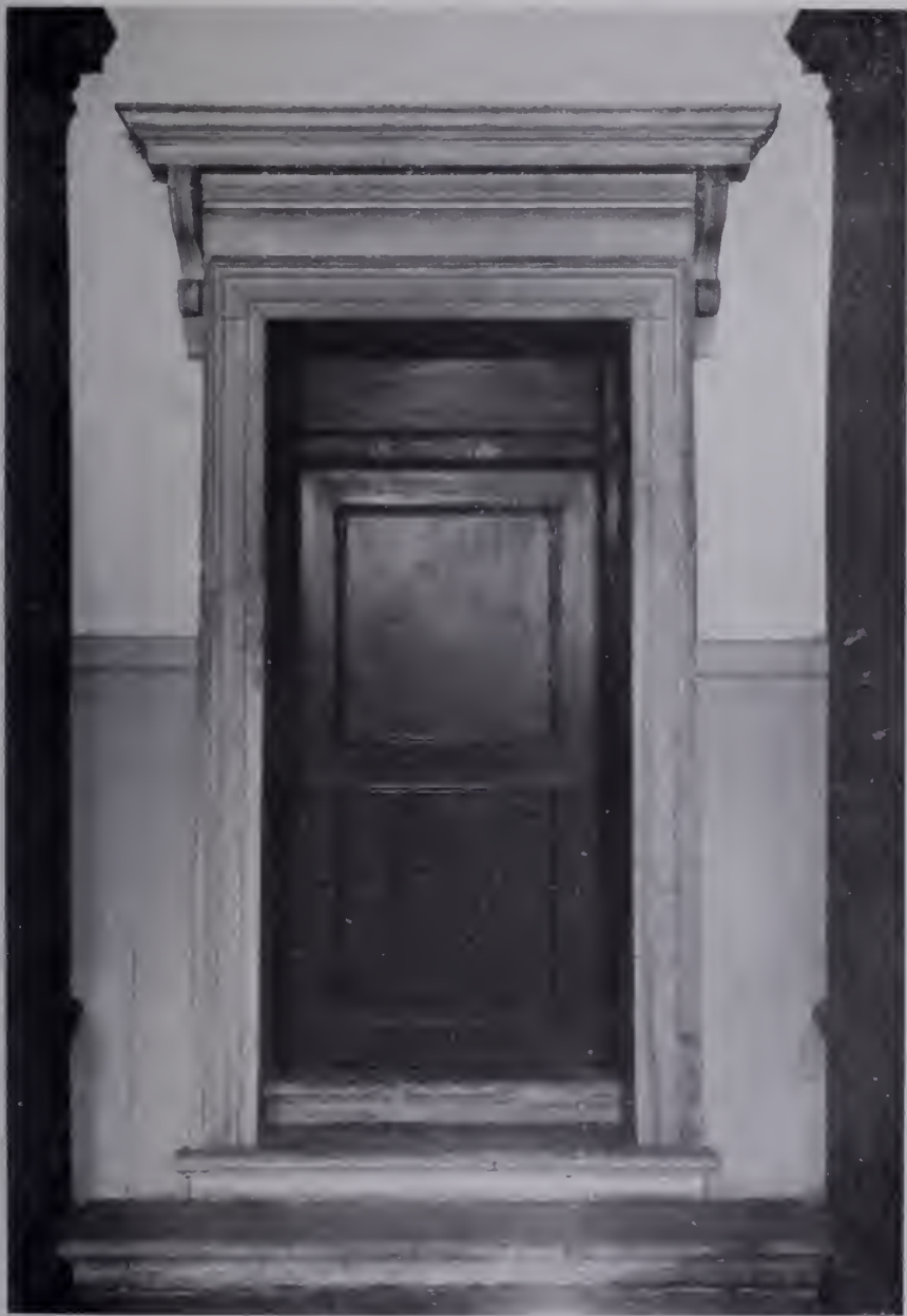
Fig. 325 — Venezia, Convento della Carità. Palladio; Porta di accesso alla sagrestia. (Fot. Ceccato).
