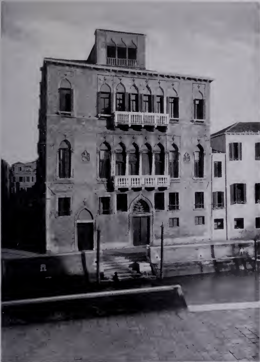
Fig. 138 — Venezia, Palazzo Nani a San Trovaso. Jacopo Sansovino (attribuito a): Facciata. (Fot. Fiorentini).
