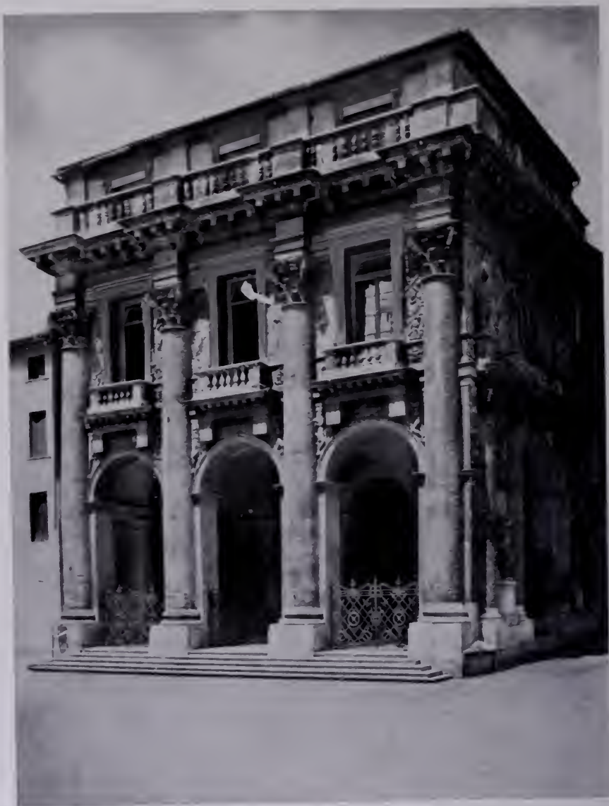
Fig 434 — Vicenza, Loggia del Capitano. Palladio: Facciata. (Fot. Alinari).
