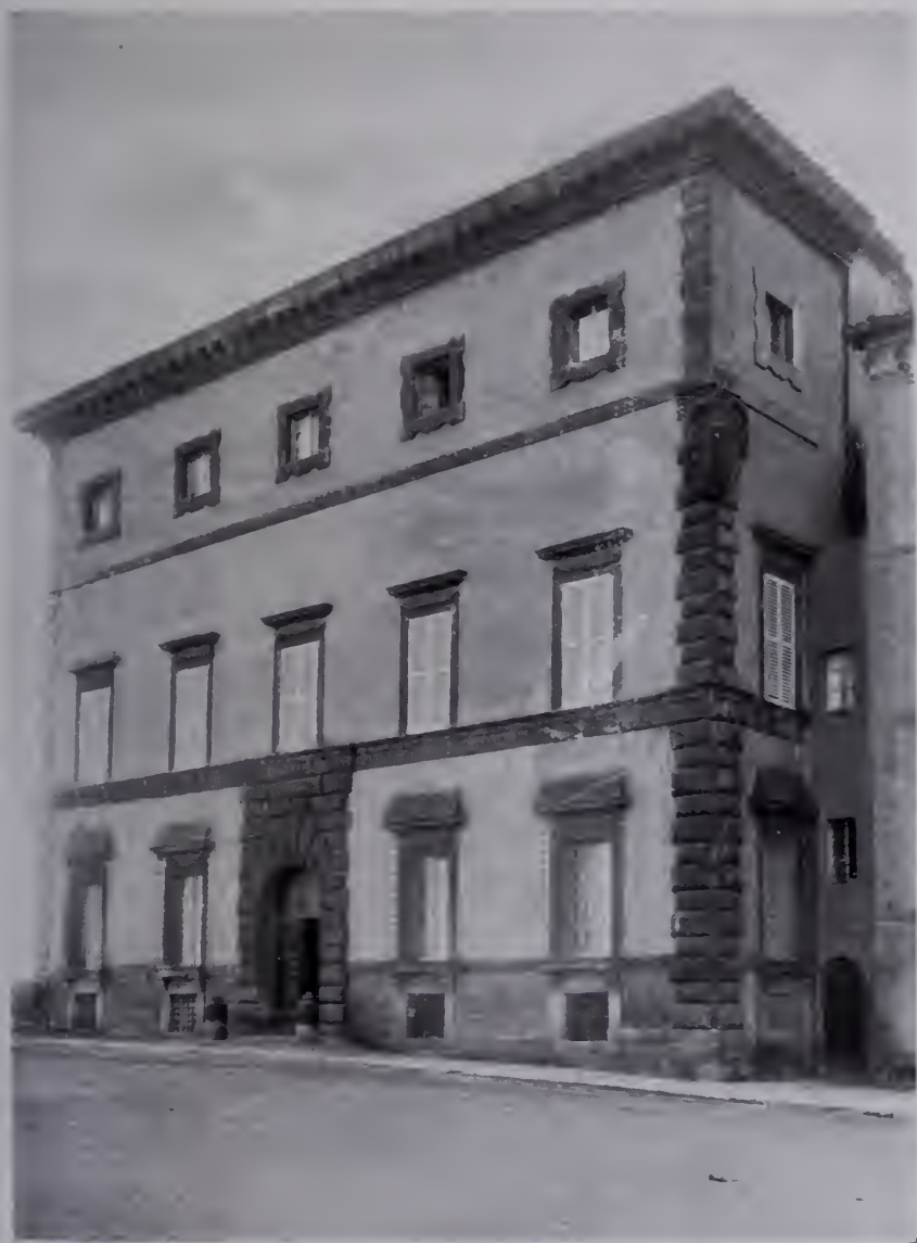
Fig. 541 — Todi. Palazzo di Viviano Atti. Alessi: Facciata. (Fot. Ursini).
