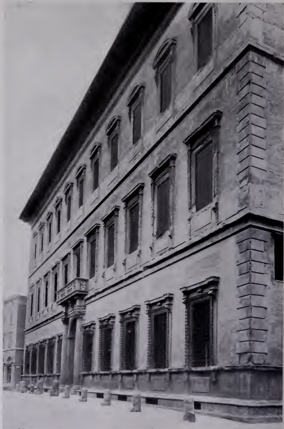
Fig. 824 — Bologna, Palazzo Bentivoglio. Francesco Morandi: Facciata. (Fot. Enea Croci).
