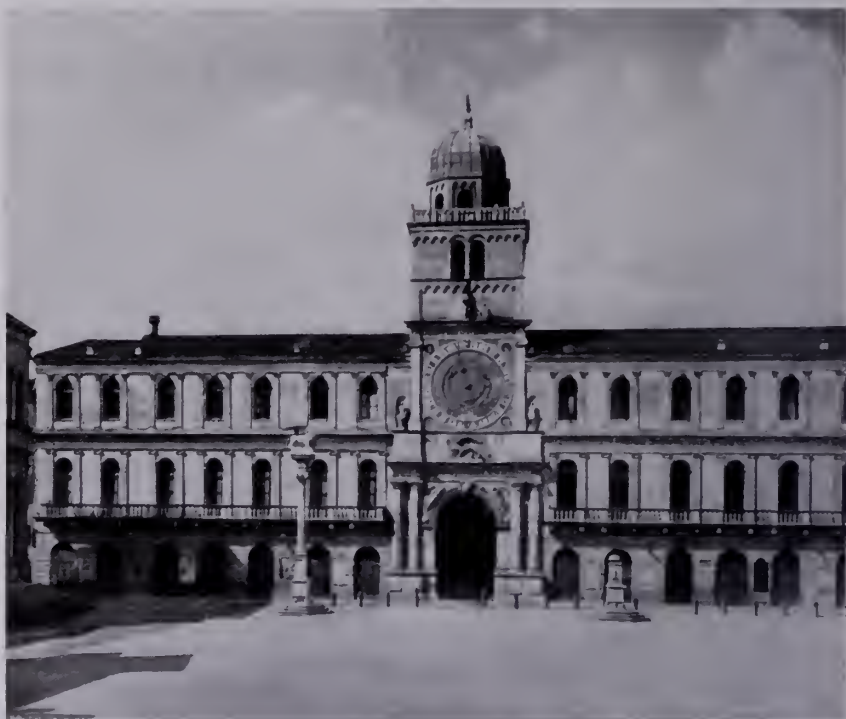
Fig. 23 — Padova, Piazza e Palazzo del Capitano con torre dell'orologio. Falconetto; Parte mediana. (Fot. Anderson).
