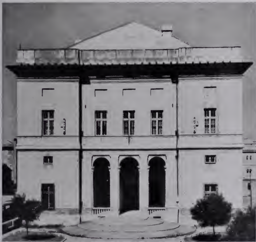
Fig. 638 — Genova, Palazzo detto della Fortezza a Sampierdarena. Bernardo Spazio, aiuto di Galeazzo Alessi: Altra facciata. (Dal Labò).
