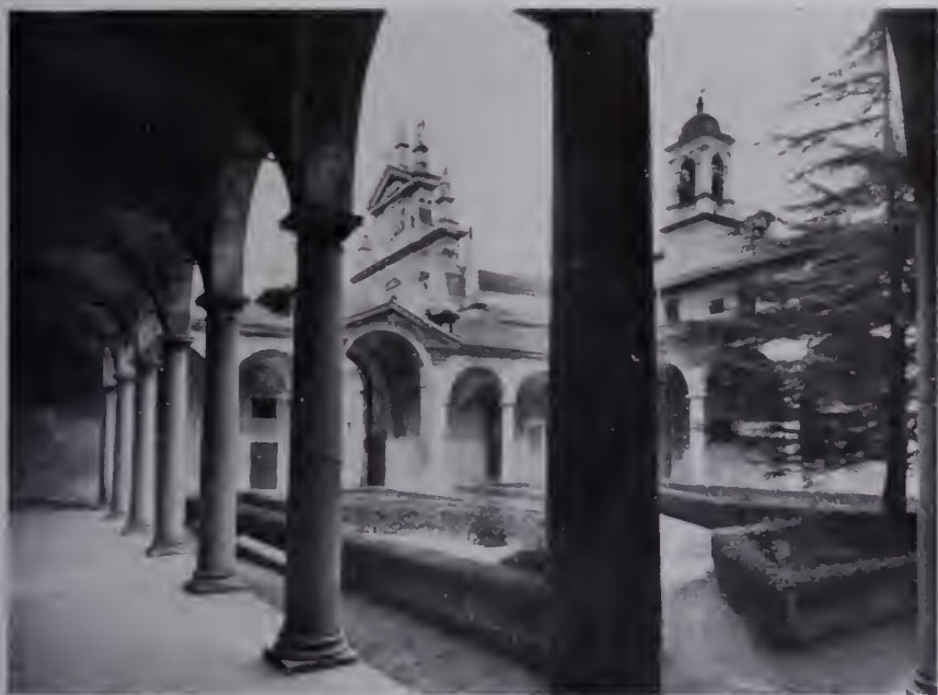
Fig. 572 — Milano, Certosa di Garegnano. Alessi: Chiostro attiguo alla chiesa. [Fot. Ceccato].
