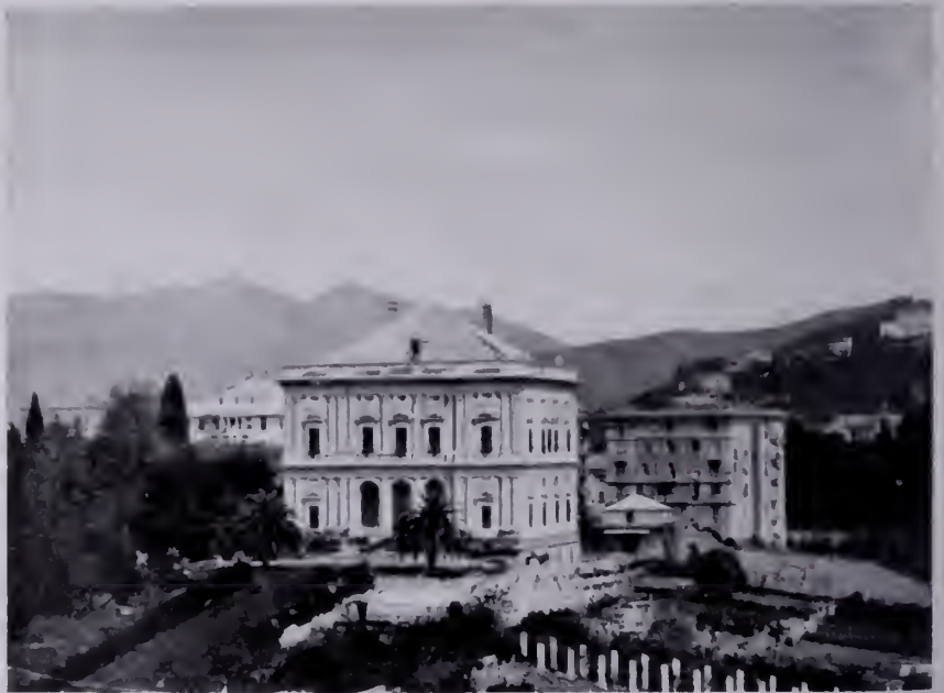
Fig. 537 — Genova, Villa Cambiaso. Alessi: Esterno. (Per cortesia del Municipio di Genova).
