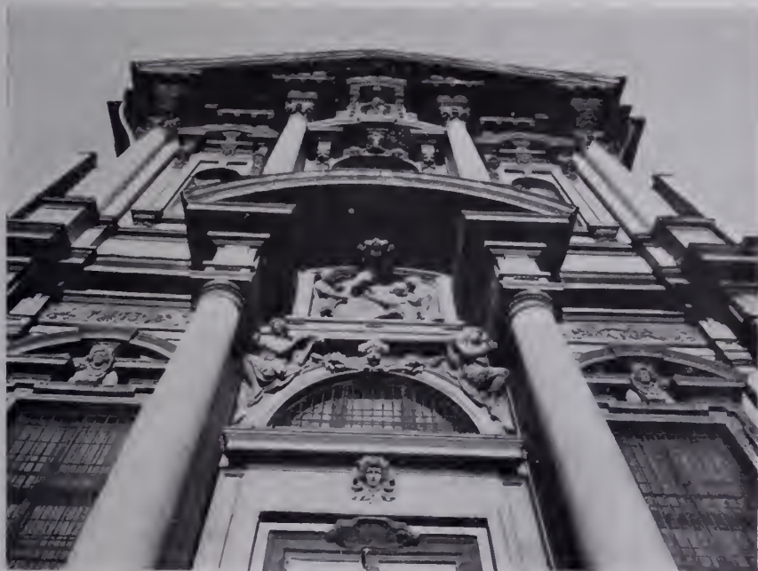
Fig. 797 — Milano, San Paolo. Giov. Battista Crespi, detto il Cerano: Parte superiore della facciata. (Fot. Ceccato).
