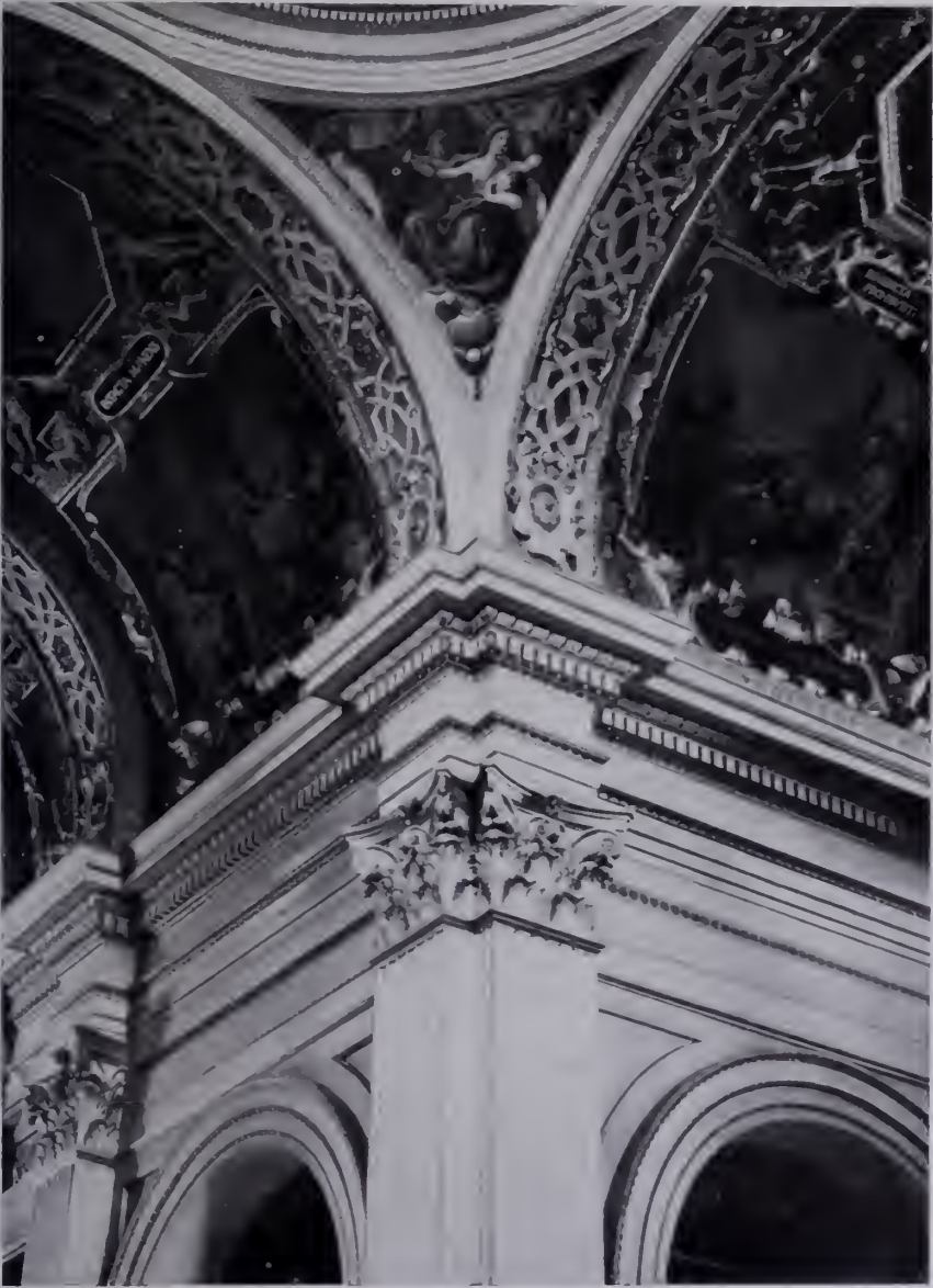
Fig. 885 -- Reggio Emilia, Chiesa della Madonna della Ghiara. Francesco Pacchioni: Arcata di sostegno alla cupola. (Fot. Ceccato).
