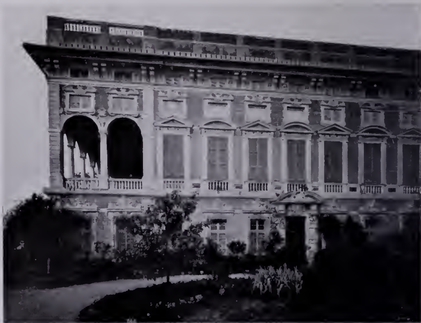
Fig. 643 — Genova, Palazzo detto del Paradiso. Vanone: Facciata. (Per cortesia dell'Istituto italiano d'arti grafiche).
