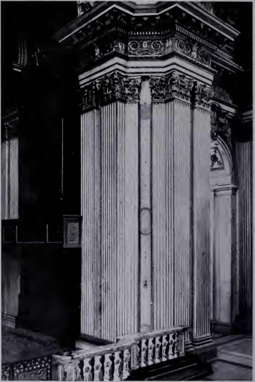
Fig. 585 — Milano, San Vittore Grande, Alessi: Fascio di pilastri a sostegno della cupola. (Fot. Ceccato).
