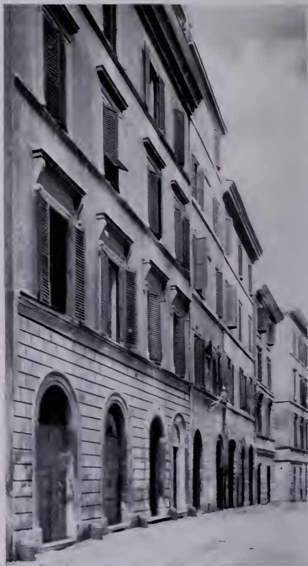
Fig. 70 — Roma. Via Banchi Nuovi. Jacopo Sansovino (attr. a) Palazzo Strozzi, esterno. (Fot. del R. Gabinetto fotografico Naz.)
