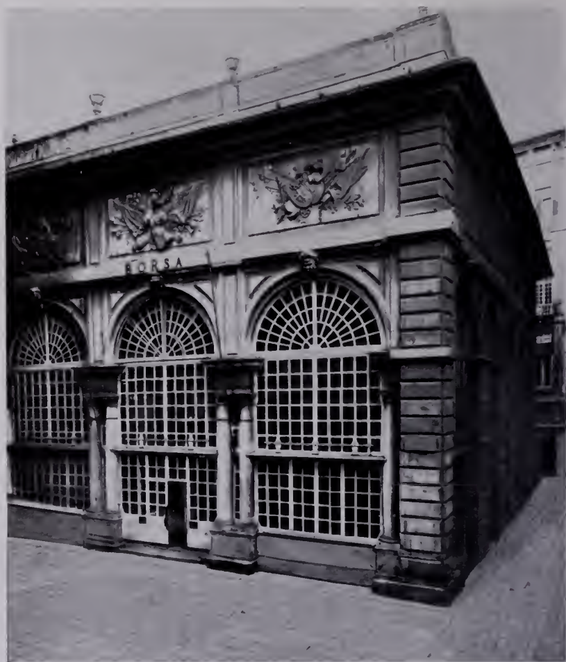
Fig. 611 — Genova, Loggia dei Banchi. Vanone: Facciata. (Per cortesia del Municipio di Genova).
