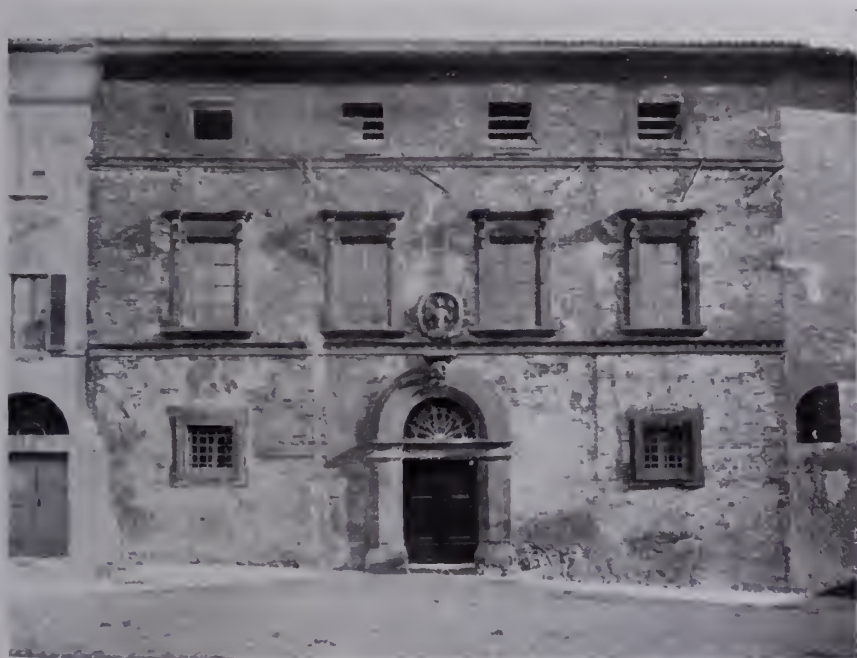
Fig. 549 — Città della Pieve, Palazzo Baglioni ora Orfanotrofio. Alessi: Facciata. (Fot. Ursini).
