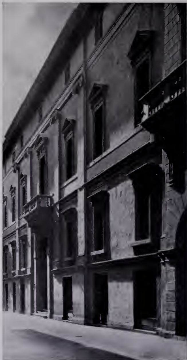
Fig. 832 — Bologna, Palazzo già Castelli. Domenico Tibaldi: Facciata. (Fot. Ceccato).
