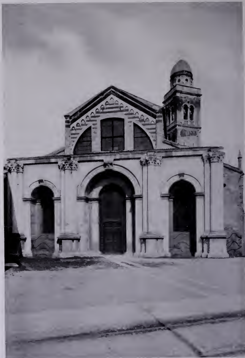
Fig. 236 — Verona, Santa Maria in Organo. Michele Sanmicheli: Rivestimento di parte dell'antica facciata. (Fot. Fiorentini).
