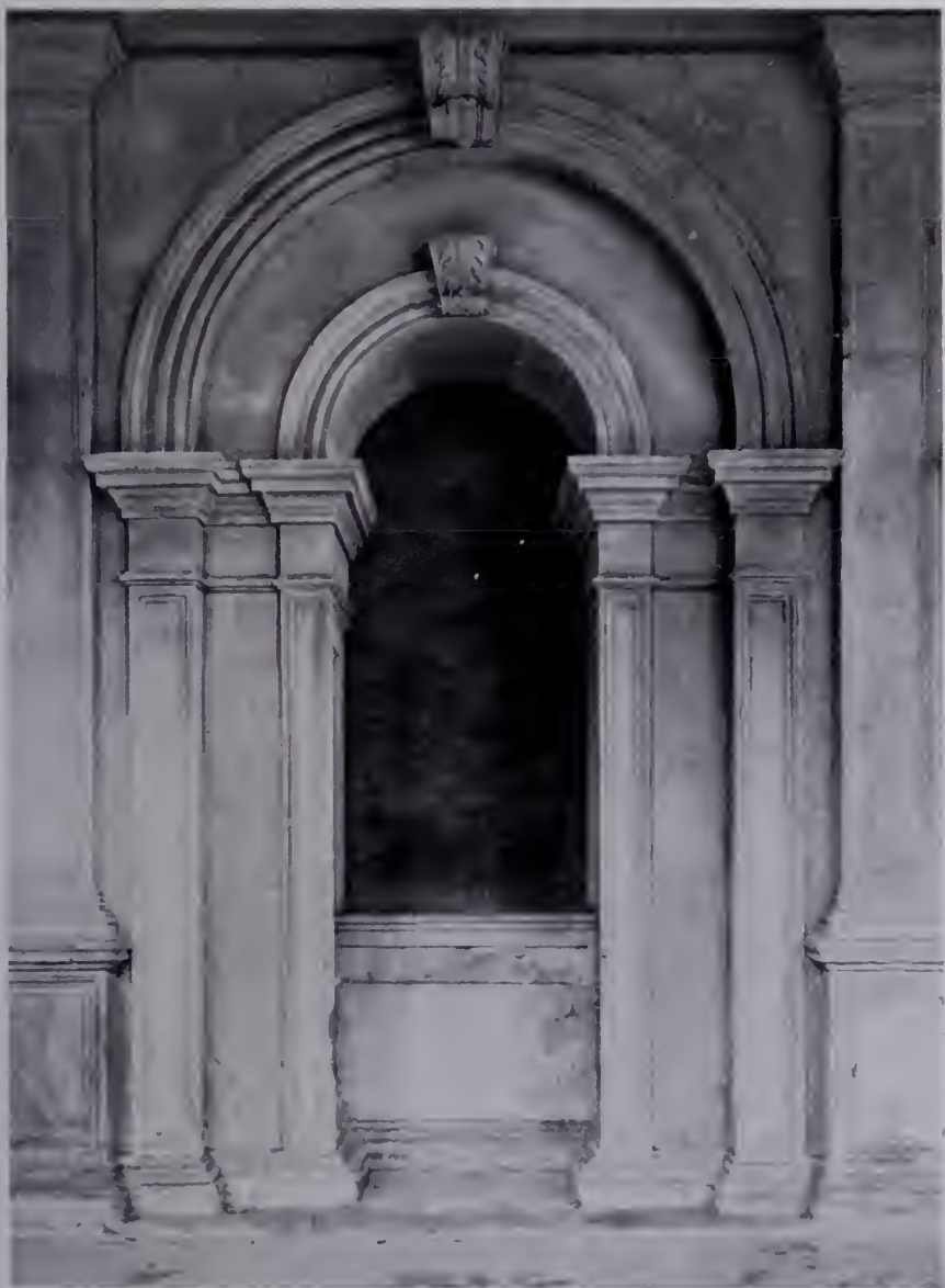
Fig. 3 — Padova, Loggia Cornaro. Falconetto: Nicchia ad arco sotto la loggia. (Fot. Fiorentini).
