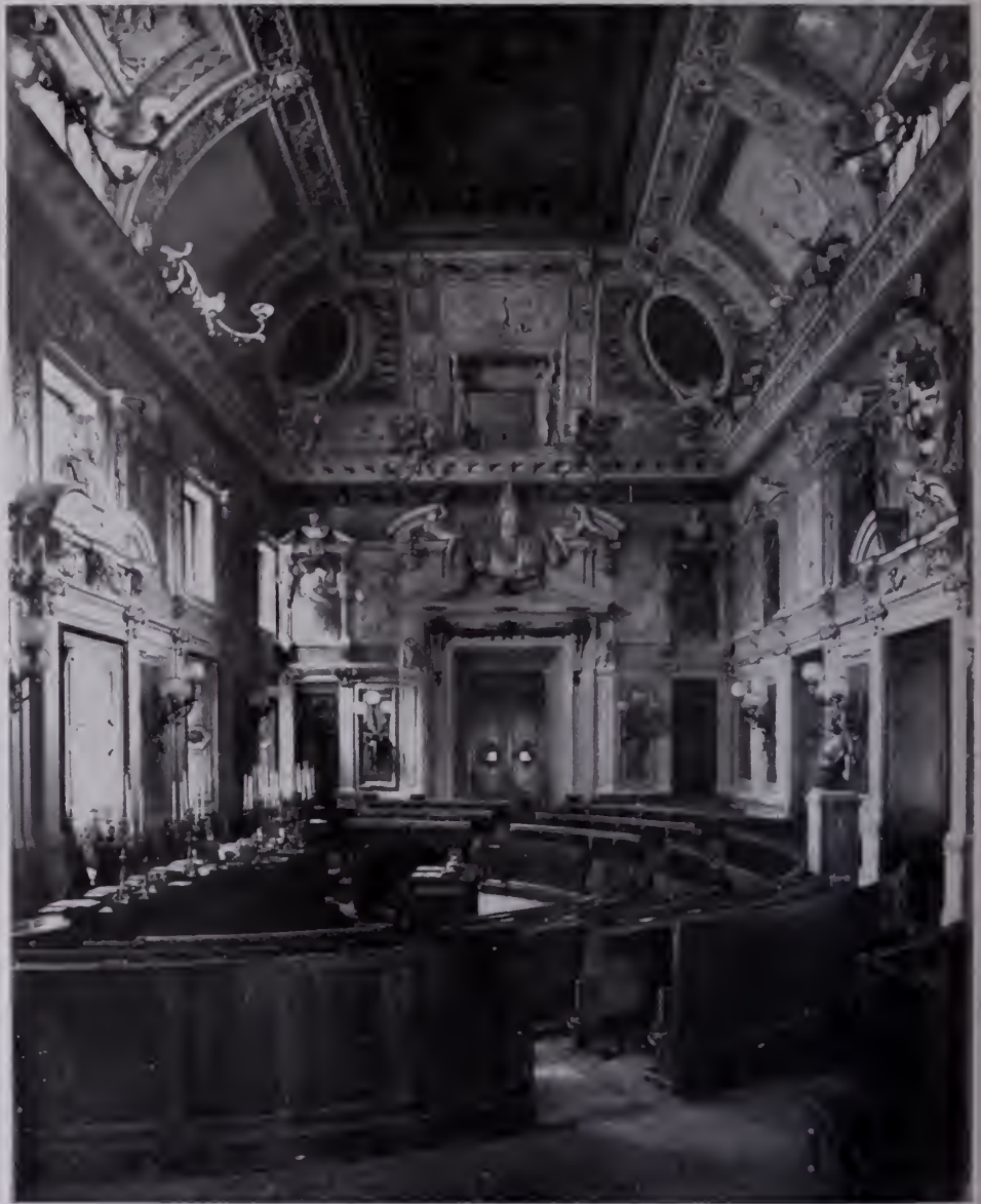
Fig. 559 — Milano, Palazzo Marino. Alessi: Salone. (Fot. Brogi).
