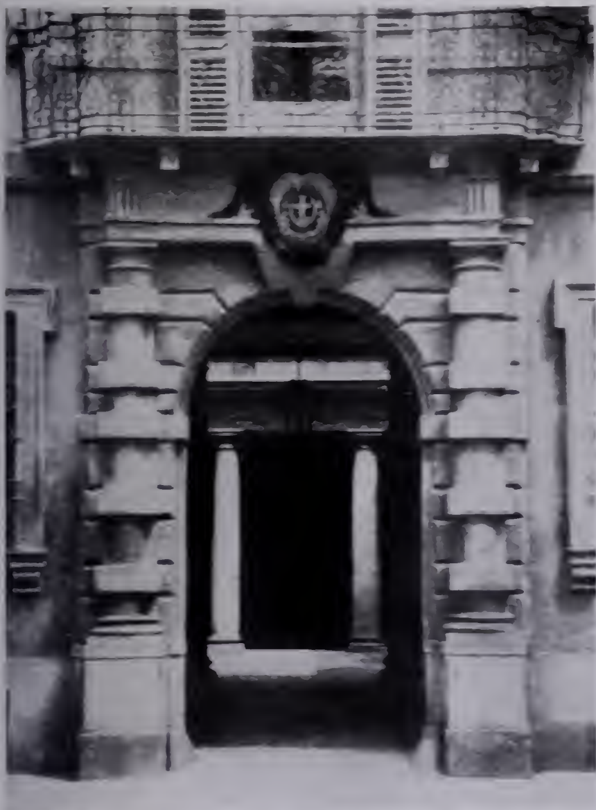
Fig. 17. — Napoli. Palazzo Natta del 1830. Pellegrino Tibaldi. Porta d'ingresso, con balaustrata per i tetti aggiunti. Dati pubblicati con il R. edit.
