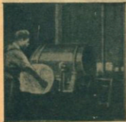
左圖表示棉花折理後的情形，這時已經十分潔白，又經過一種打棉機，使體更加潔白。右圖中經過打棉機之後，即入梳棉機，把棉刺成線狀，就是普通叫的條子。
