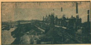
現代的鋼鐵廠
