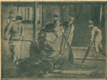
除殺禽畜的動物皮外，又有許多從國外運來的鹽醃皮和乾燥皮。這圖所示的就把牠們先投入一個含有化學品的水坑中，使牠們變軟。
