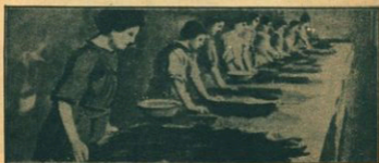
熟皮在未染色之前，必須塗上許多潤滑的混合物，才能發光，這是由女工所做的。
