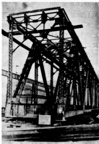
照54桁梁在工廠中試裝
