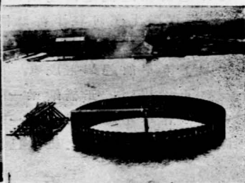
照62原第十四號橋墩之鋼板樁圍套
