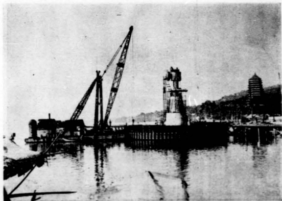
67拔第一號墩鋼板橋
