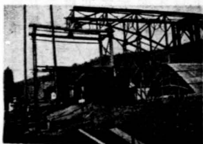
59拱橋在工廠中試裝
