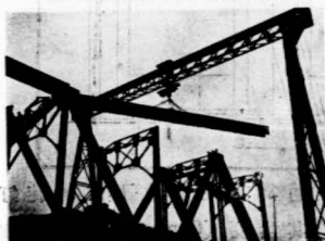
照51用吊架安裝上弦之情形
