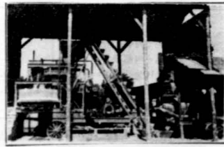
材料拌合機尾部
