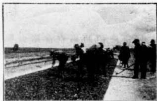
鋪耙材料於路基上
