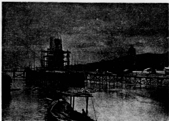
照01第一號橋墩建築時情形
