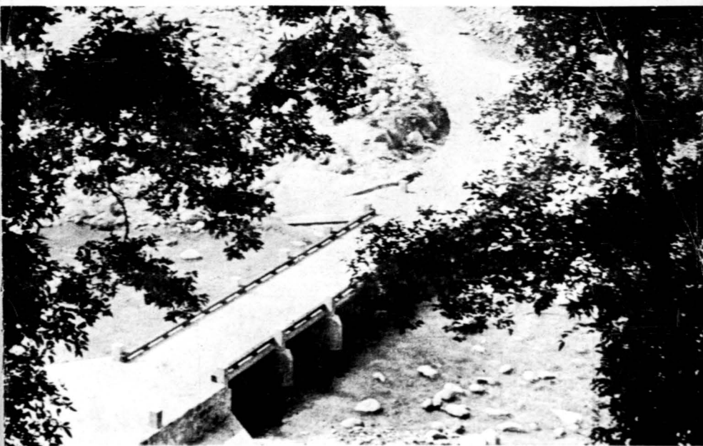
西溪公路馬道過水橋
