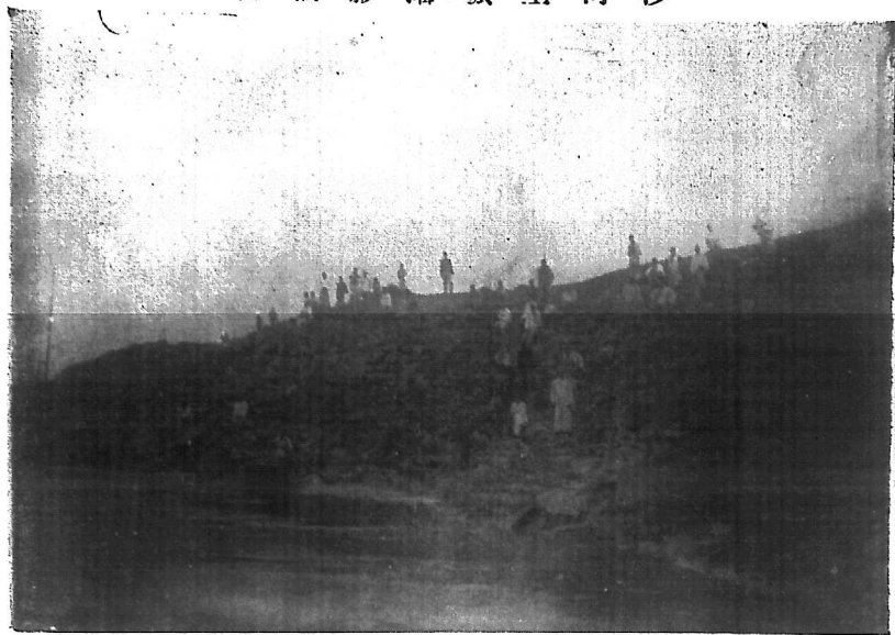
第四段修築古城石堤竣工
