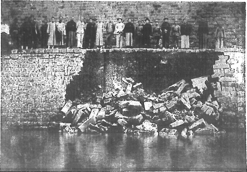
河南海城縣南門外石堤坍塌情形之二
