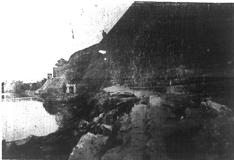
修築西門外石堤工程竣工之四
