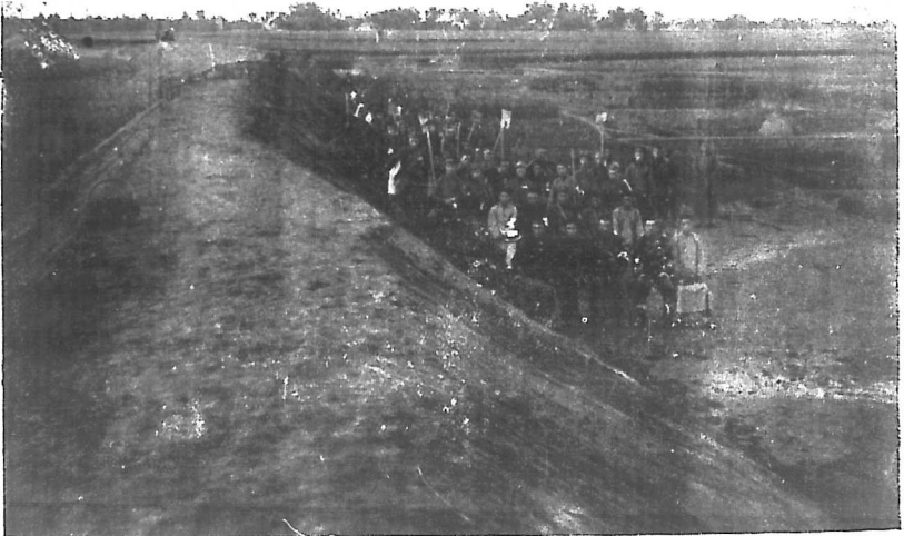
第三段汝河東岸店張月堤竣工
