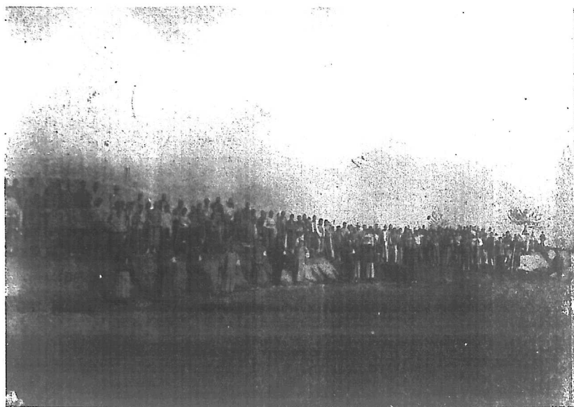
第四段鞏縣蘇村堤開工
