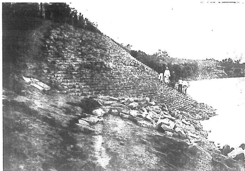
第五段黑龍潭石壩竣工
