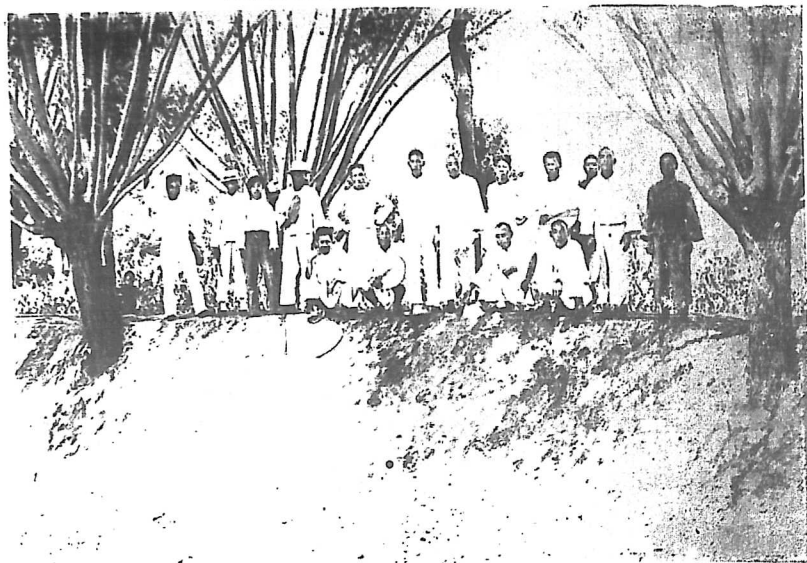
第二段修築優師伊河南岸堤竣工
