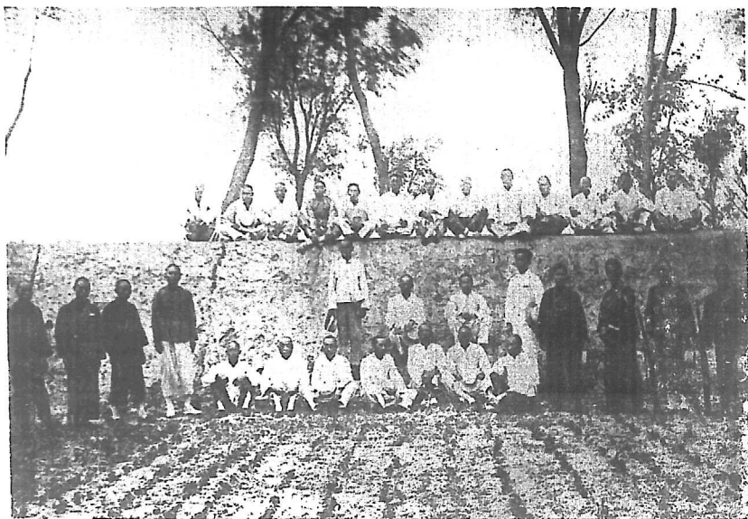
第二段修築師洛河北岸堤竣工
