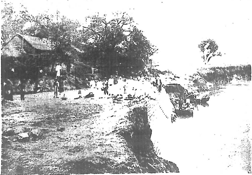
第三段建設襄城三里溝石壩竣工
