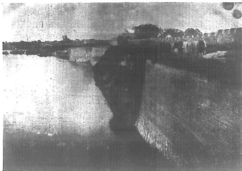
第七段修築周南口第二節石堤竣工
