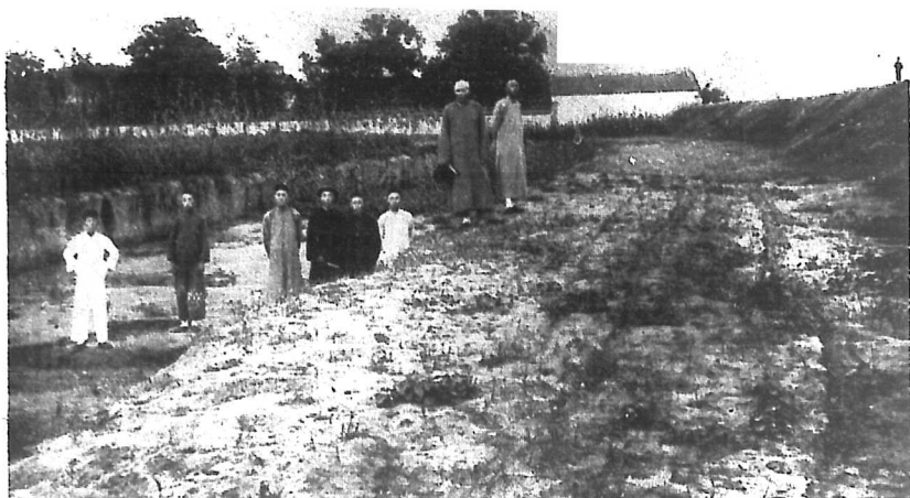
修築福音堂西首土堤竣工
