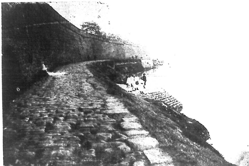
第三段建築襄城南門外小字壩竣工
