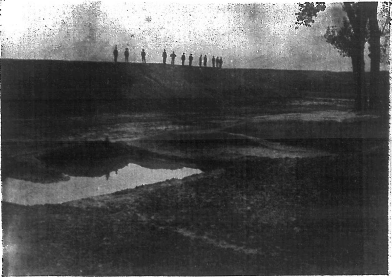
第四段北舞渡東關外南岸新築堤收工
