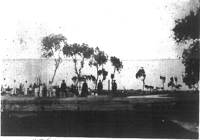
狀現塞淤橋石及況概作工橋勒乾段二第 近分一第
