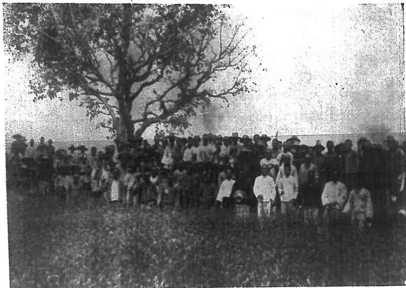
第二段修築優境伊河南岸堤開工
