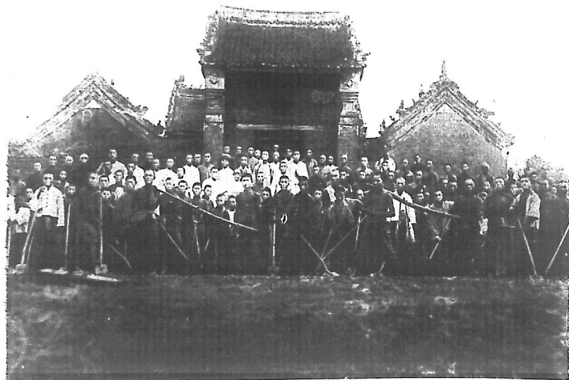
鄆城縣乾河振工第一階段工程
