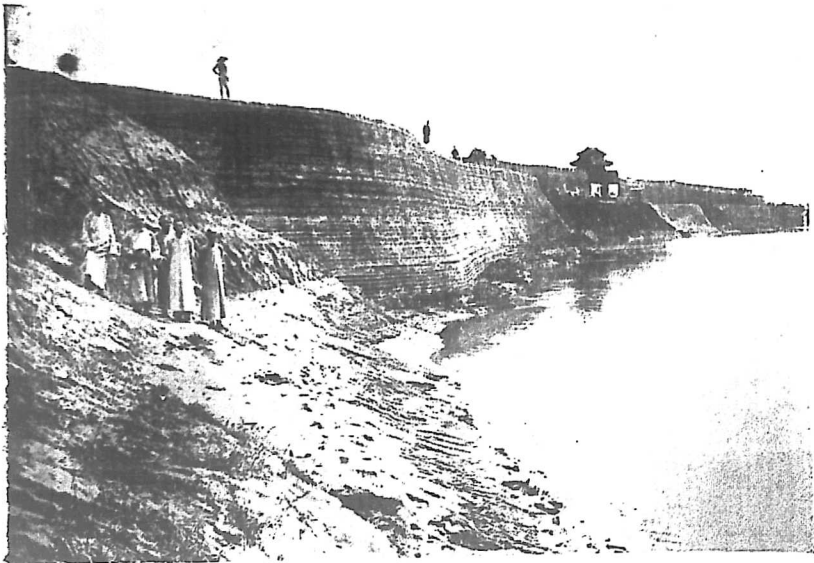
修築鄆城西關外石堤工程竣工之一
