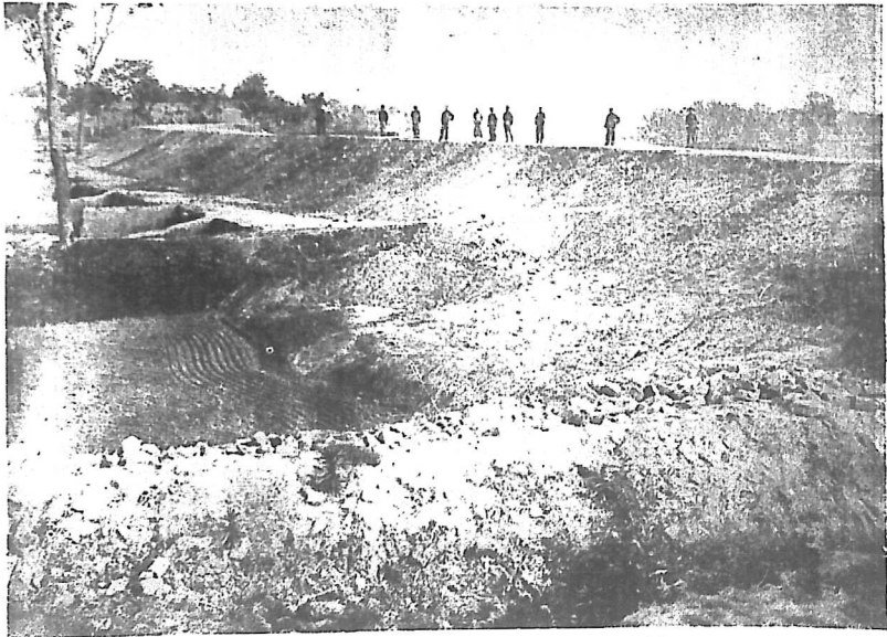
第四段北舞渡外東北岸新築堤收工
