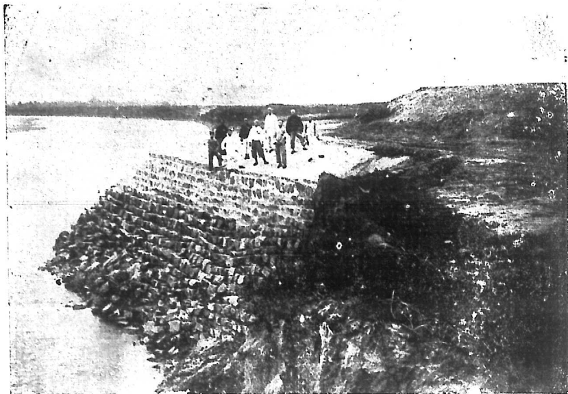
第一隊山羊石壩竣工
