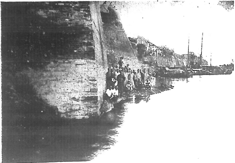
第七段修築北口第二節磚石堤竣工
