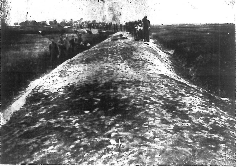
第三段新築八里窰月堤工情形
