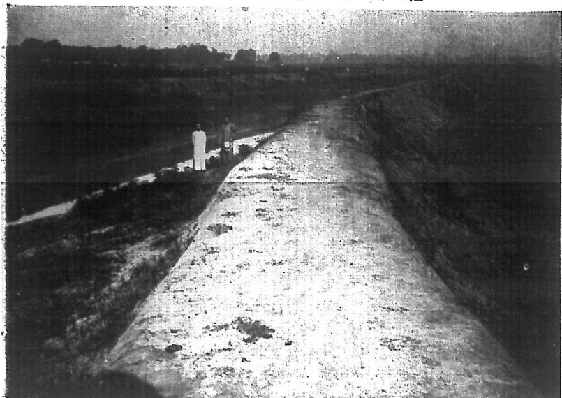
修築乾河土堤
