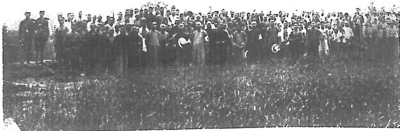
第四段羅莊堤開工
