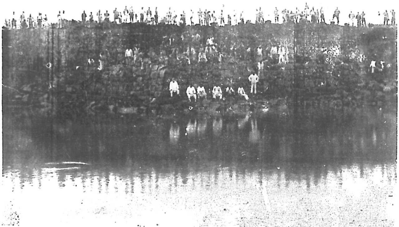
第二段建築東岸陽縣梅灣第一石壩工作情況
