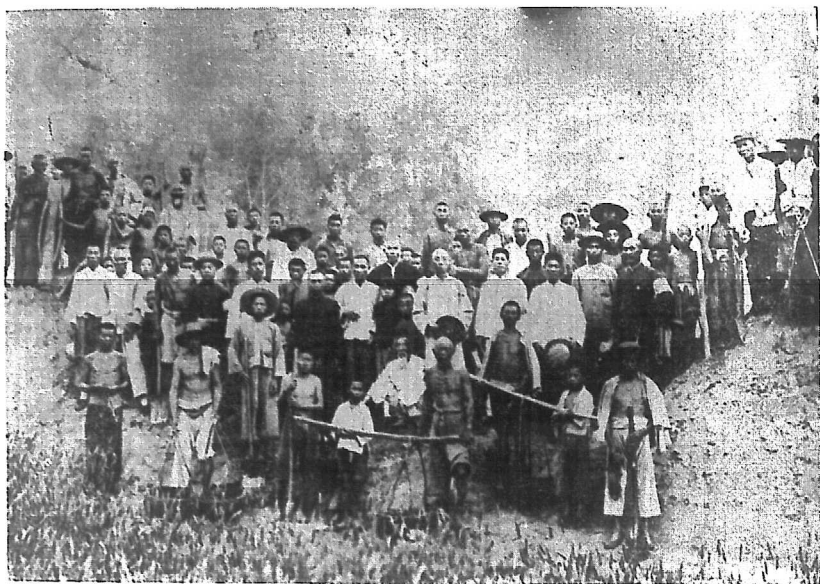
第二段修築堰境洛河南岸堤開工
