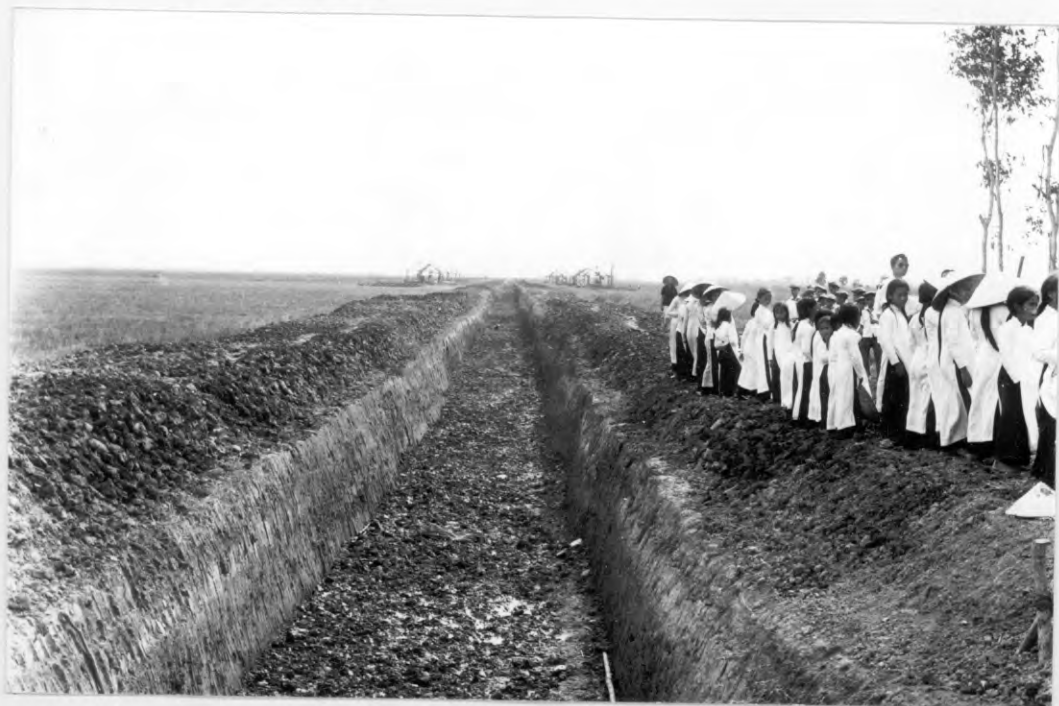
Un tronçon de canal nouvellement creusé à Ấp-Bắc (Plaine des Jongs).
