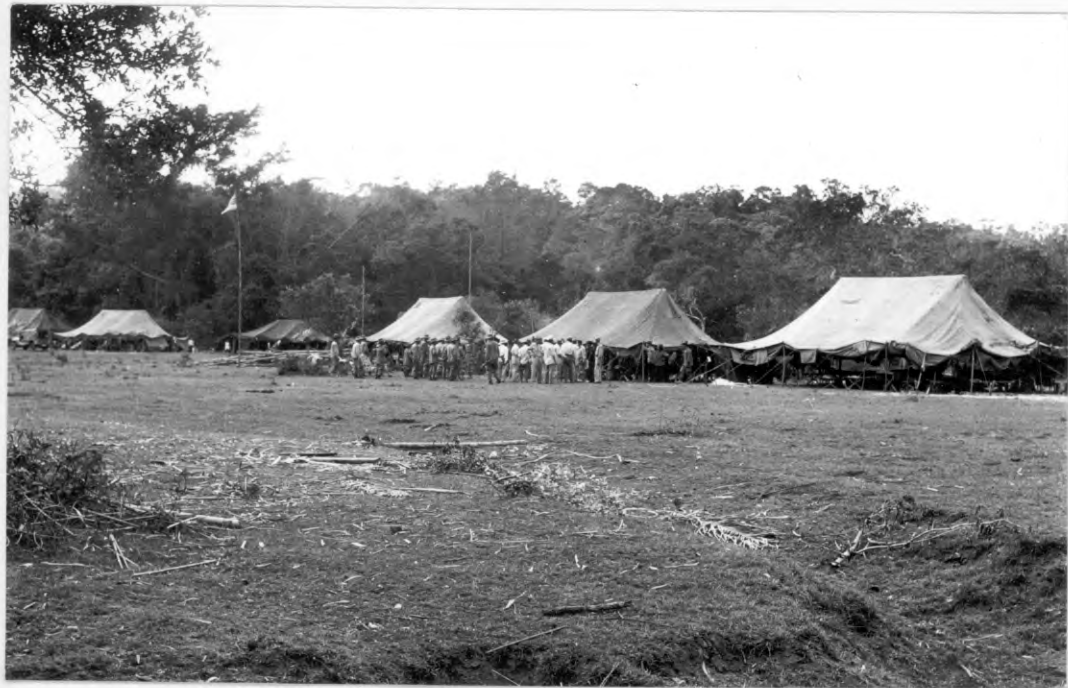
Des logements provisoires sont érigés sur un terrain nouvellement déblayé pour l'accueil des transplantés. Temporary reception centers for new settlers on land recently cleared.
