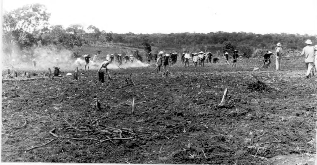
Défrichement à la main. Clearing by hand.
