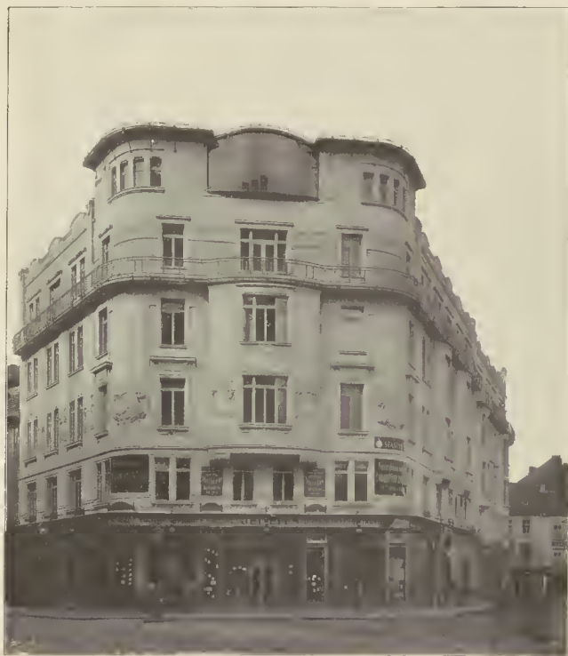
Zwei Zinshäuser beim Pulverturm in Prag. Vom Architekten B. Bendelmayer.
