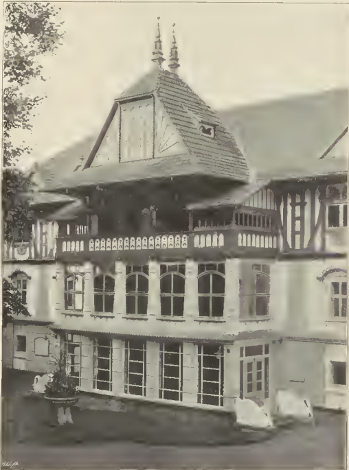
Mineral-Badehaus. Eingang in die Halle.
