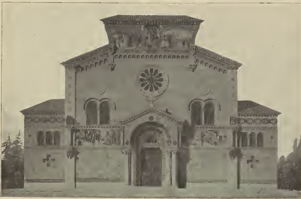
Umbau einer Kirche in Görz. Vom Architekten Antonio Lasciac.
