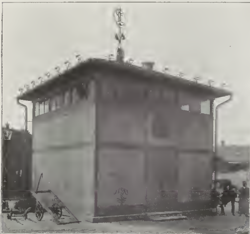
Eingeschaltete Station der städtischen Elektrizitätswerke auf dem Naschmarkt in Wien. Entworfen und ausgeführt vom Eisenwerk R. Ph. Wagner.
