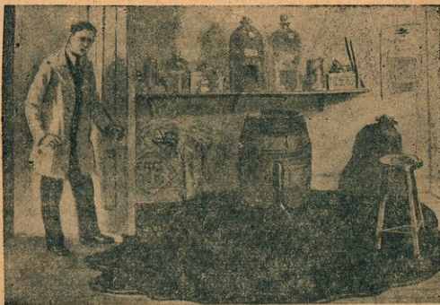
圖 142. 一桶瀝青，未放塞子，在試驗室裏，過了一夜以後，瀝青都流佈地板面上。瀝青雖然看去是固體，但它是具有黏滯性的流體。
