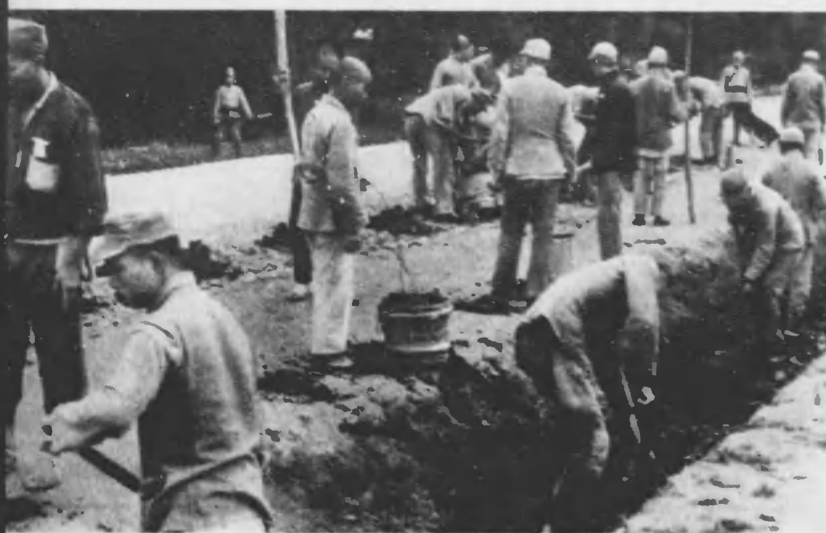
近隣補修工事に新しい勤勞の飯をふるふ捕虜部隊、建設勇士として満洲國にも數回派遣されてゐる
