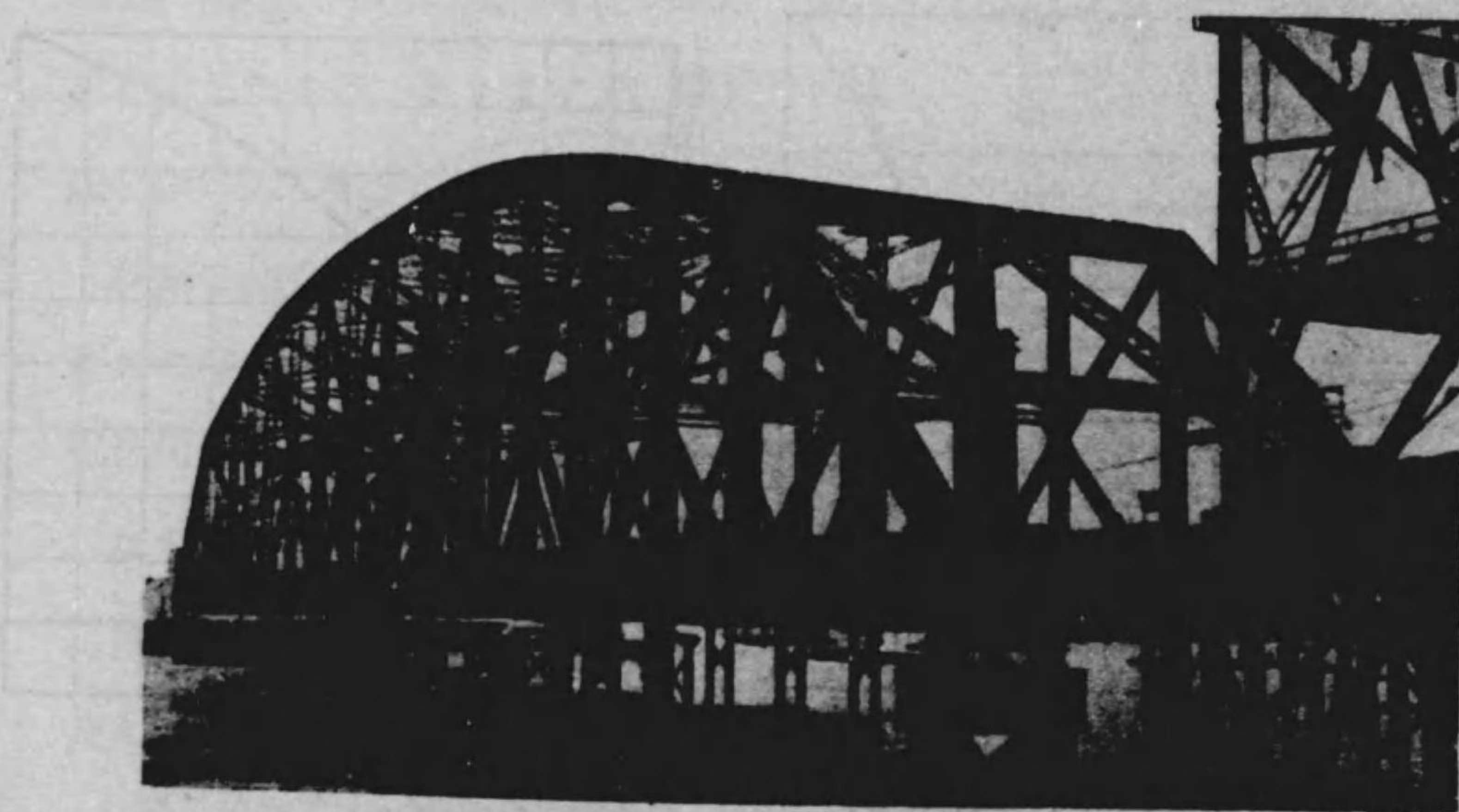
錆びない鋼で製した550米の大鐵橋。(Quebec Bridge)
