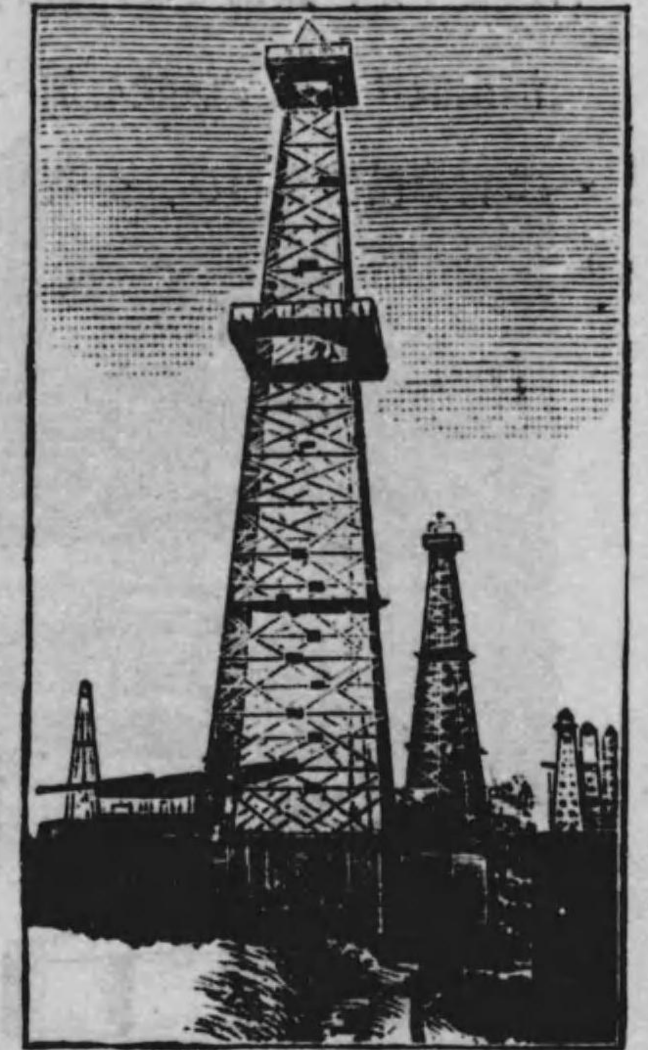
原油の汲み揚げ。水平の黑色棒は挺子で、その左端を上下すれば右端の鉛直の紐がポンプに働く。
