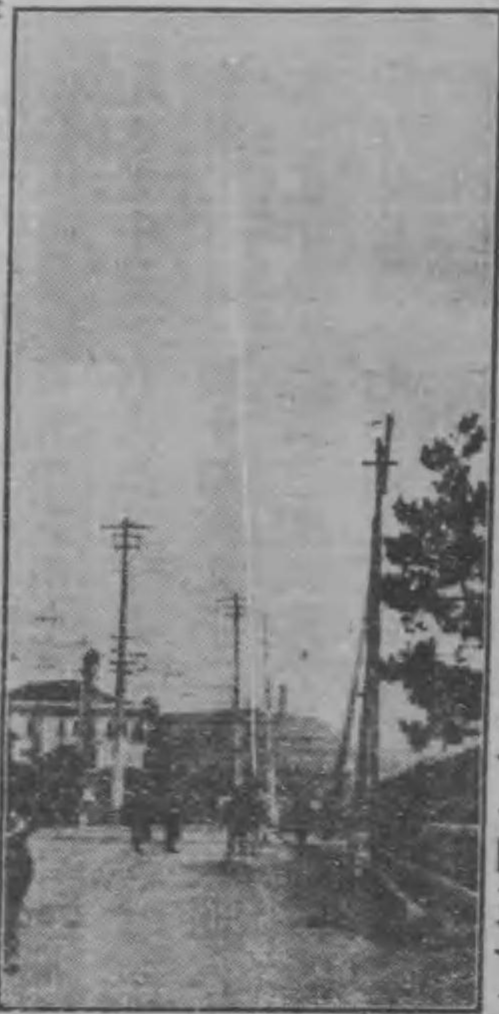
(防火栓の試験)
