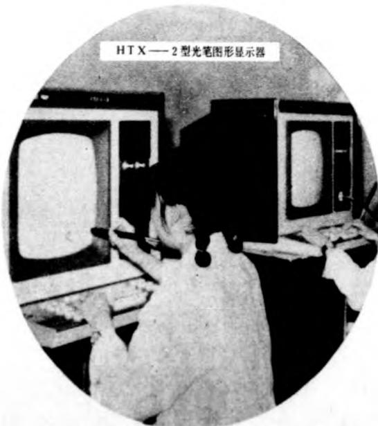
“HTX—2型光笔图形显示器”是一台不带缓冲存储器的随机扫描光笔图形显示器, 可与DJS131—1型计算机配接。
