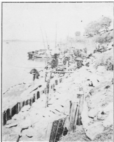
豐城縣西門外鐵牛嘴打樁情形
