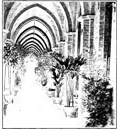
CORRIDOR OF MISERICORDIA HOSPITAL, SÃO PAULO.
