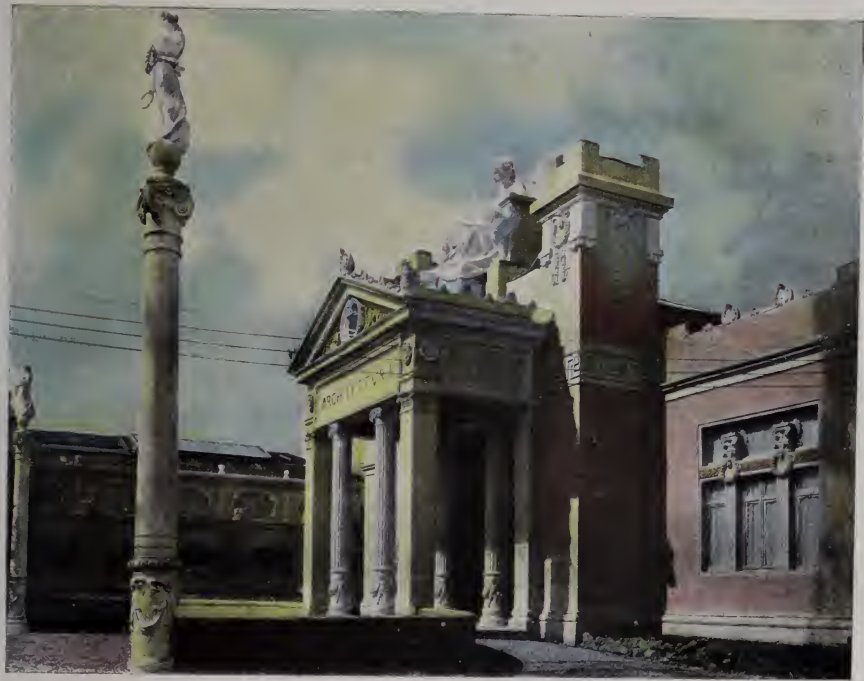
ARCHITETTURA (Arch. Locati e Bergomi).
