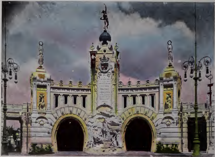
INGRESSO PRINCIPALE - INTERNO (Arch. Locati).
