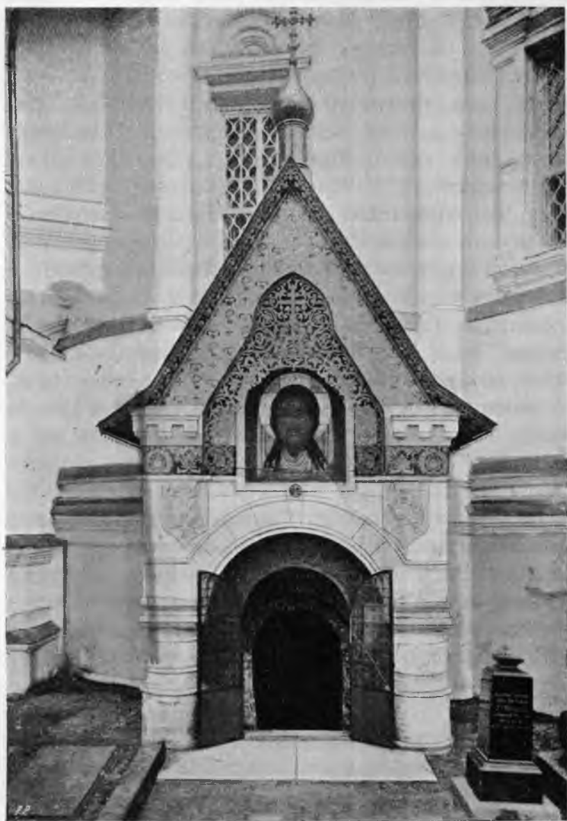
Входъ въ усыпальницу.
