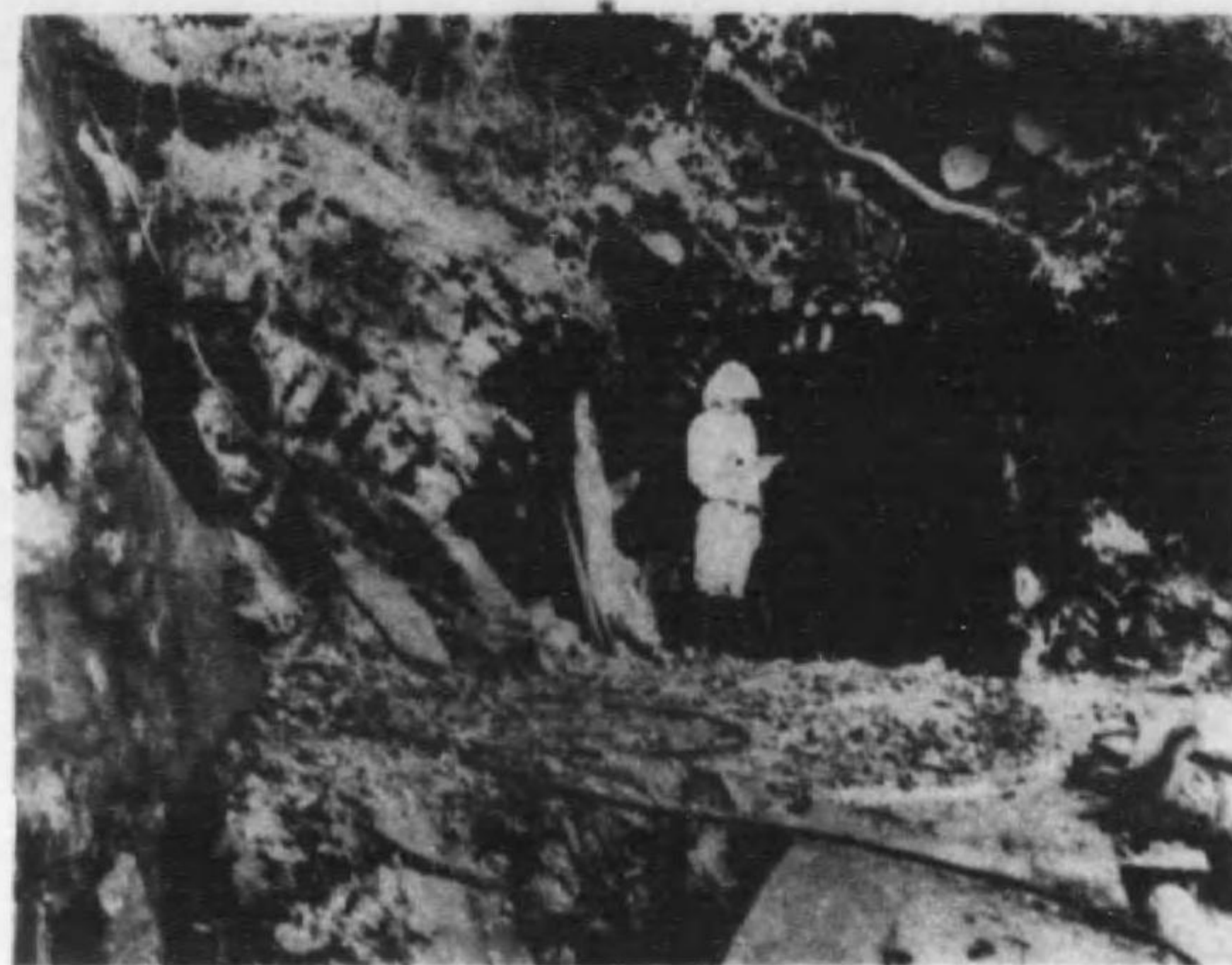
大白山鐵床 中1番坑々口露頭 イ、含銅硫化鐵鐵々帶 ロ、上磐石墨片岩 ハ、下磐石墨片岩 ニ、坑道口
