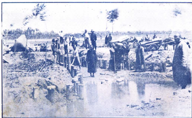
洛里溝泉築閘砸樁情形
