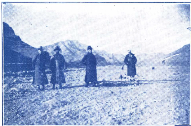
南岩根北頭山下由此開渠引水
