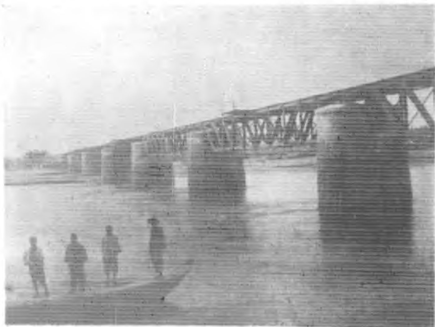
平漢路豐樂鎮漳河鐵橋
