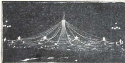
Plaza de Mayo. La iluminación.
