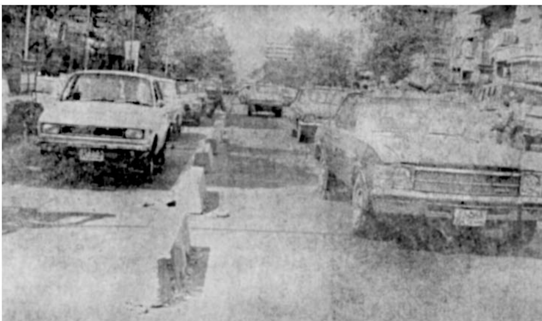
شهرداری با کارگذاشتن بلوک های سیمانی در تعدادی از خیابان های تهران مسیر اتوبوس های واحد را مشخص کرده است، احتمال میدهد با این کار سرعت اتوبوس ها از ۲۵ کیلومتر در ساعت تا ۴۵ کیلو متر در ساعت افزایش می یابد. از روز شنبه سه فروردیه هیچ اتوبیل سواری اجازه عبور از این مسیر را ندارد.
