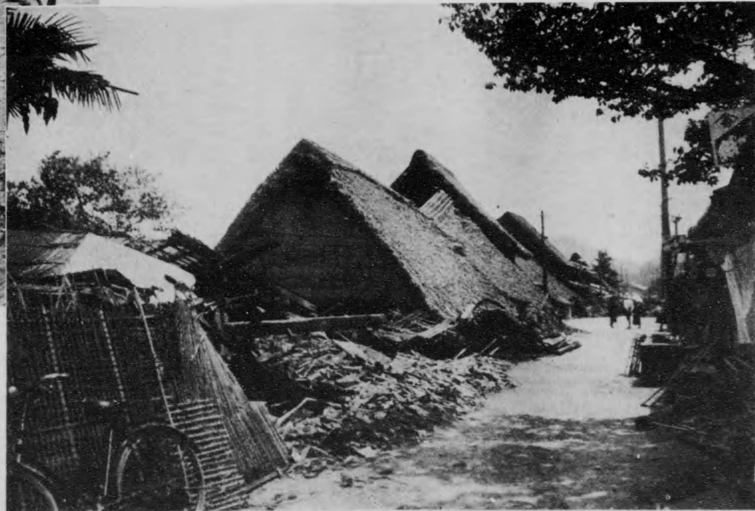
屋家潰倒の前校學小濱美久 Collapsed houses (Kumihama)
