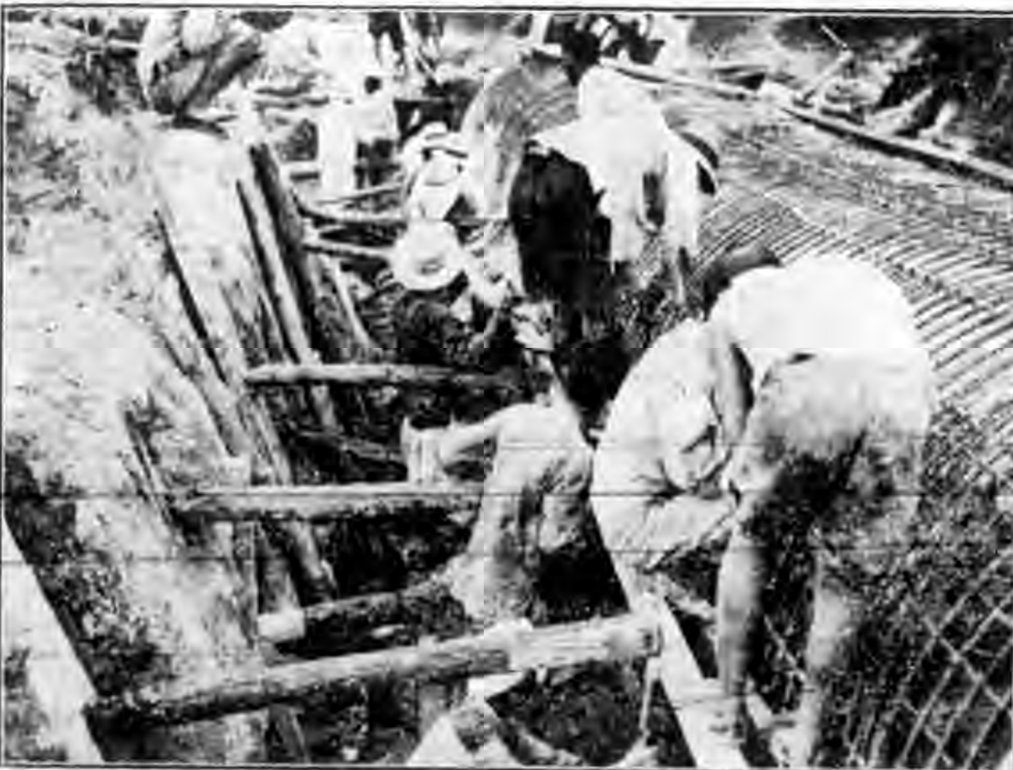
八呎管六尺徑水管就地鑄造灌注混凝土時情形
