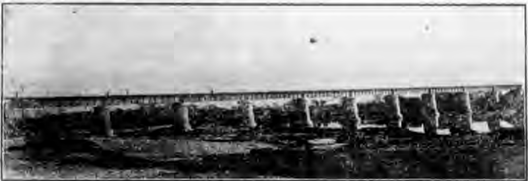
玉山信江鋼板梁大橋全景每孔20公尺共十孔
