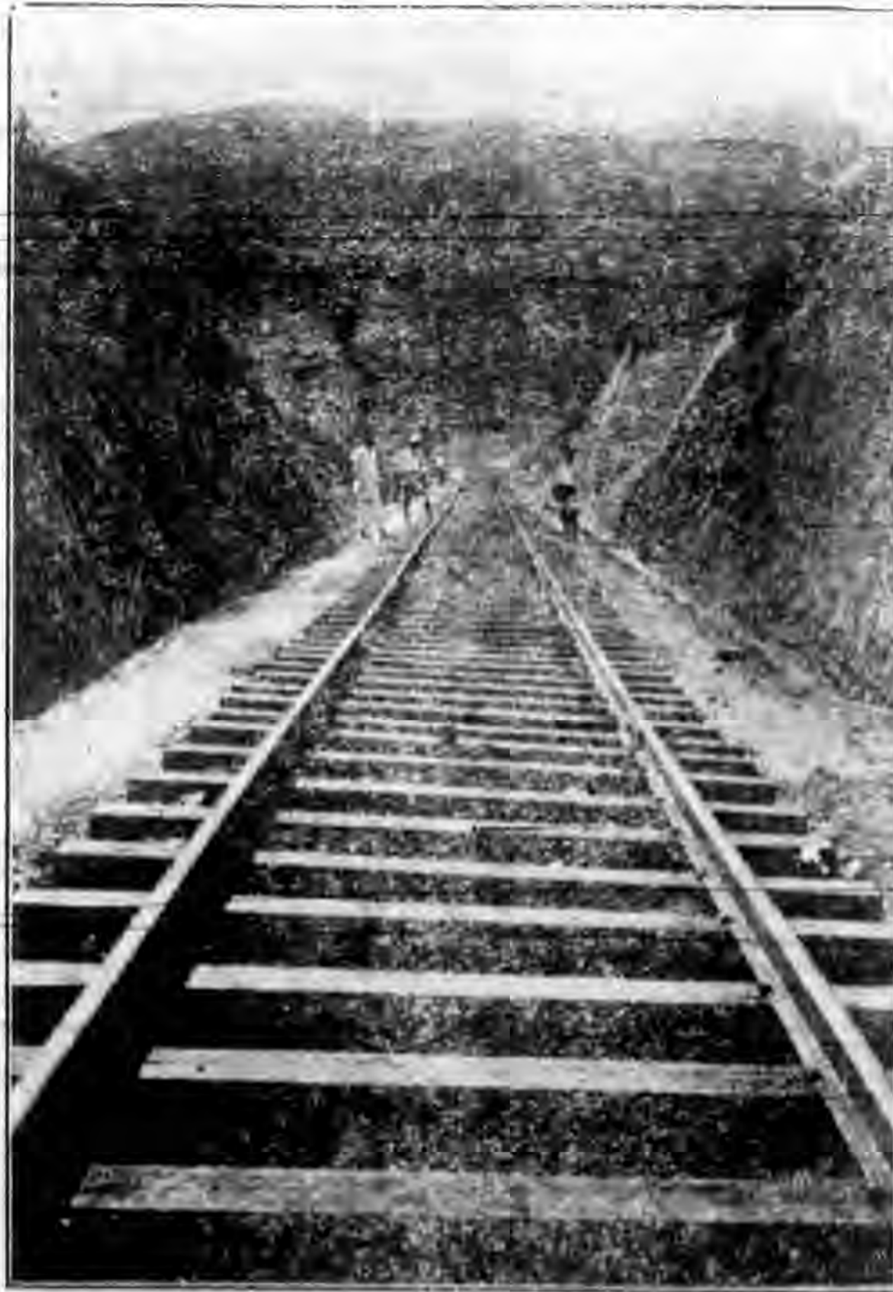
坑口切土工程
