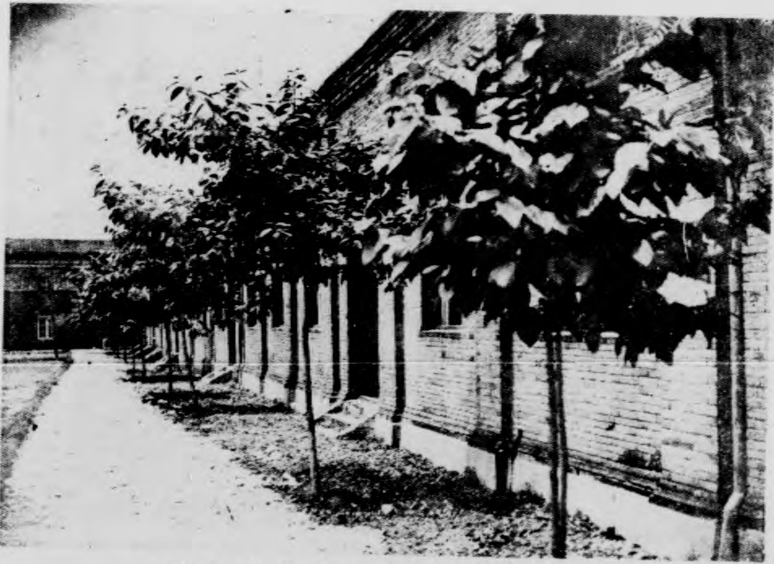
土 木 採 治 及 物 理 儀 器 室 外 景
