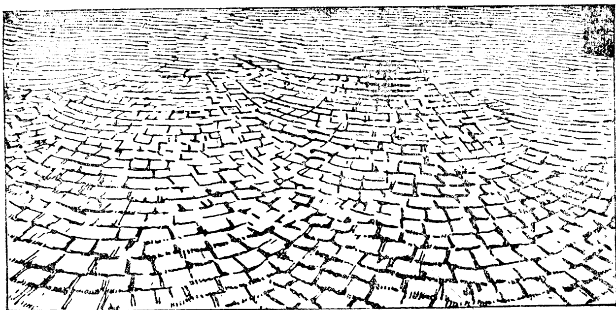
第四十七圖 倫敦拆爾息路鋪砌石塊法
