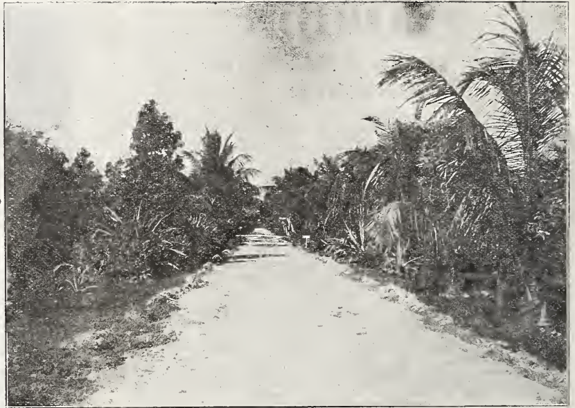
Florida Road—Dade County
