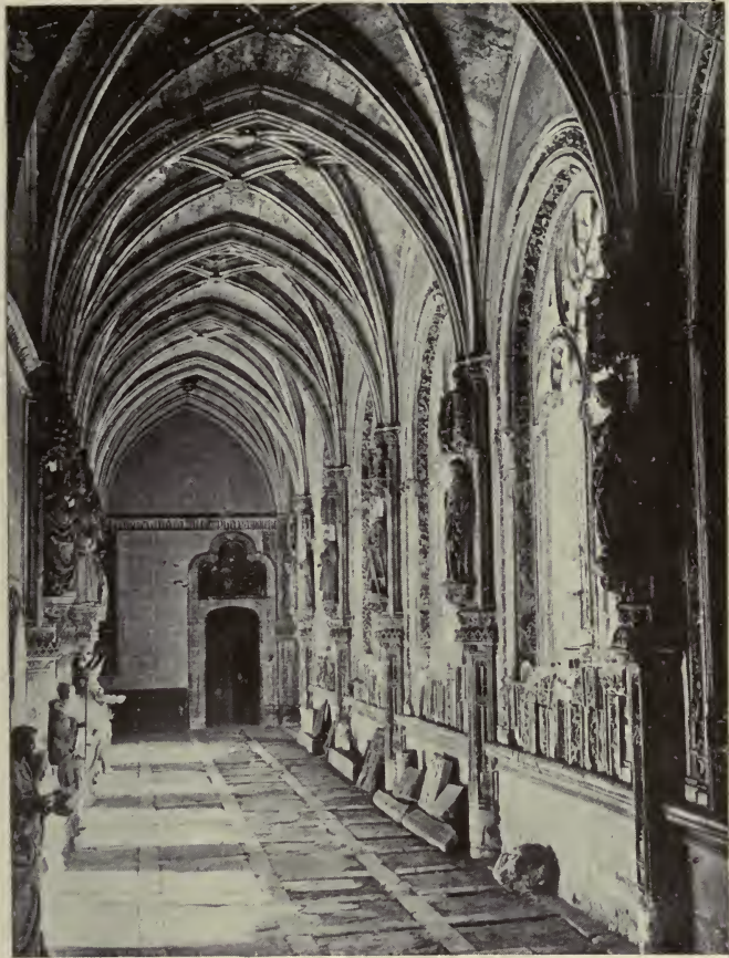
SAN JUAN DE LOS REYES. THE CLOISTERS
