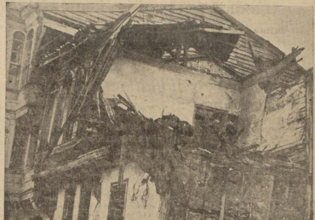
Büyük bir kısmı yıkılan bir evin korkunç hali
