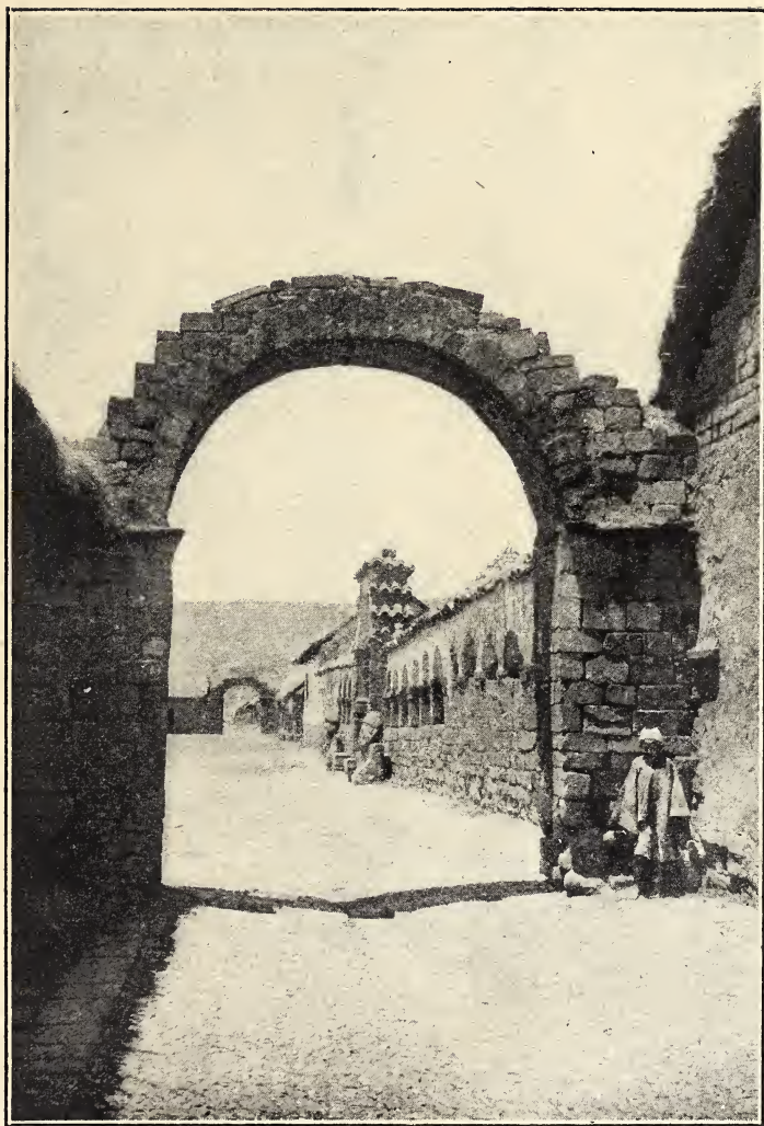
Arco de entrada a la Plaza.
