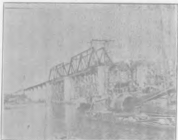
形情之工趕時同墩橋號十與架木橋便橋鋼架裝橋大河渚
