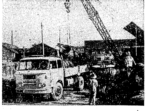
衡阳火车站提前四十天完成全年货物运输任务,被评为广州局一类货场。图为装卸情景。
