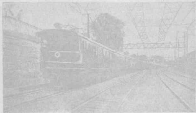
單相交流機車牽着一列客車，車頂上裝着比例磁器式的受流器。
