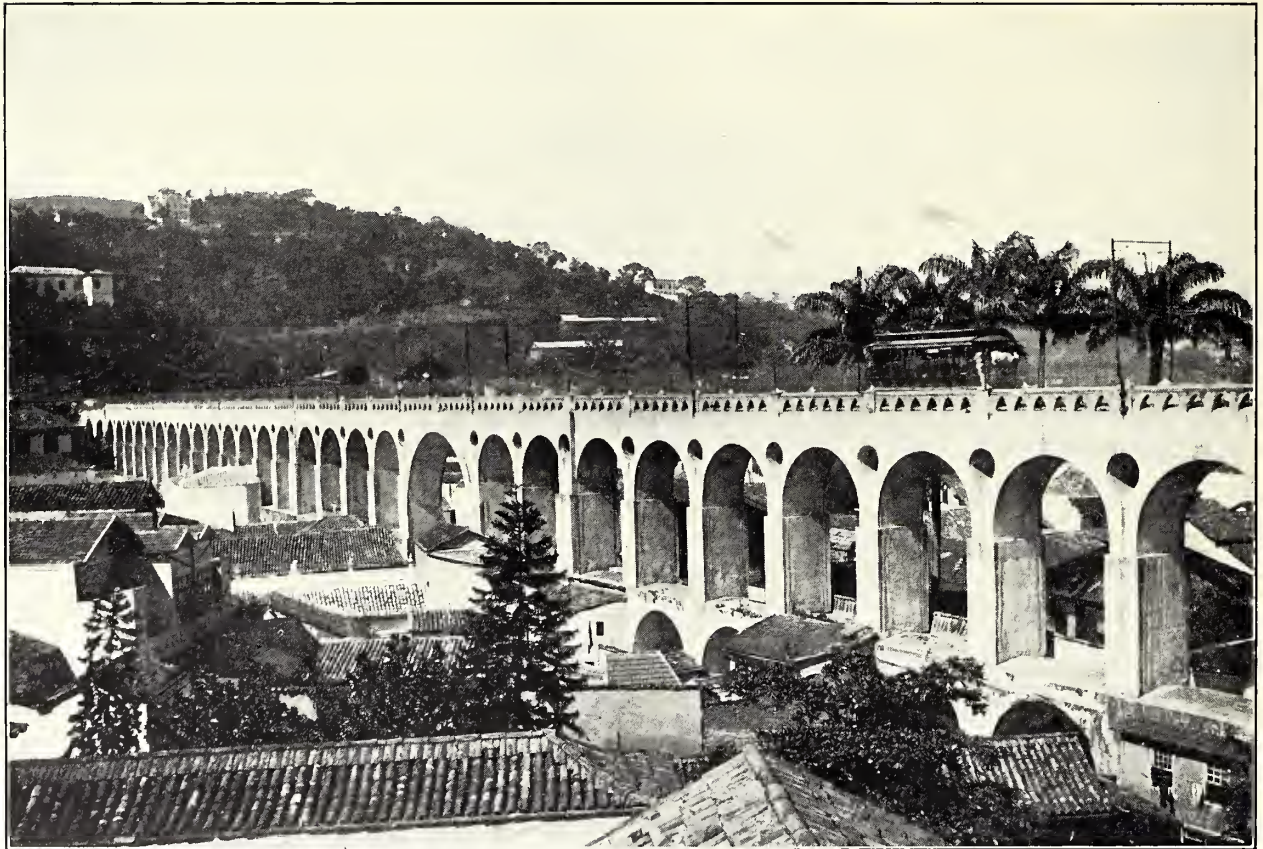
OLD CARIOCA AQUEDUCT, RIO DE JANEIRO.
