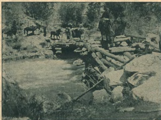
Мостъ черезъ р. Тополевку.
