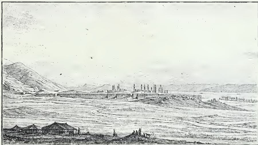
LES MONUMENTS DE PERSÉPOLIS, VUS SUR LA FACE NORD 1 .
