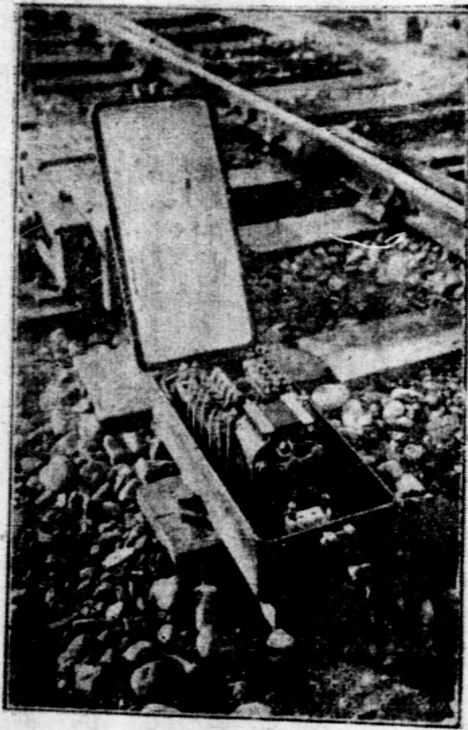
第二圖 轉轍器回路制御器 （交流）
