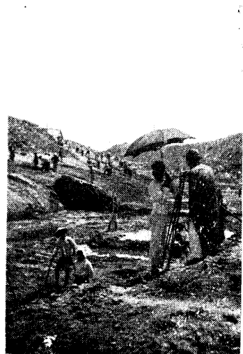
行將竣工時技術員測驗河床高度
