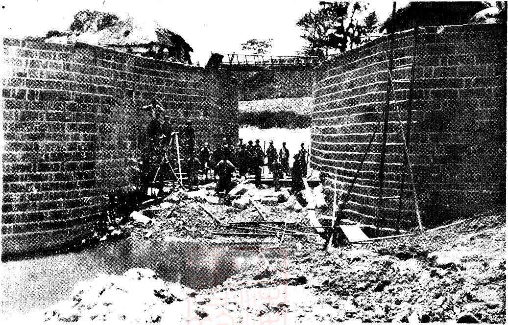
正 在 施 工 修 理 之 時 越 河 閘
