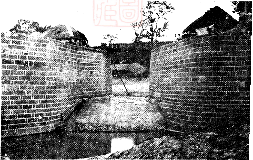
修 理 完 竣 後 之 越 河 閘
