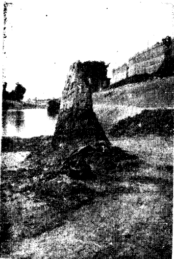
行將竣工時黃田洪啓壩之封墩
