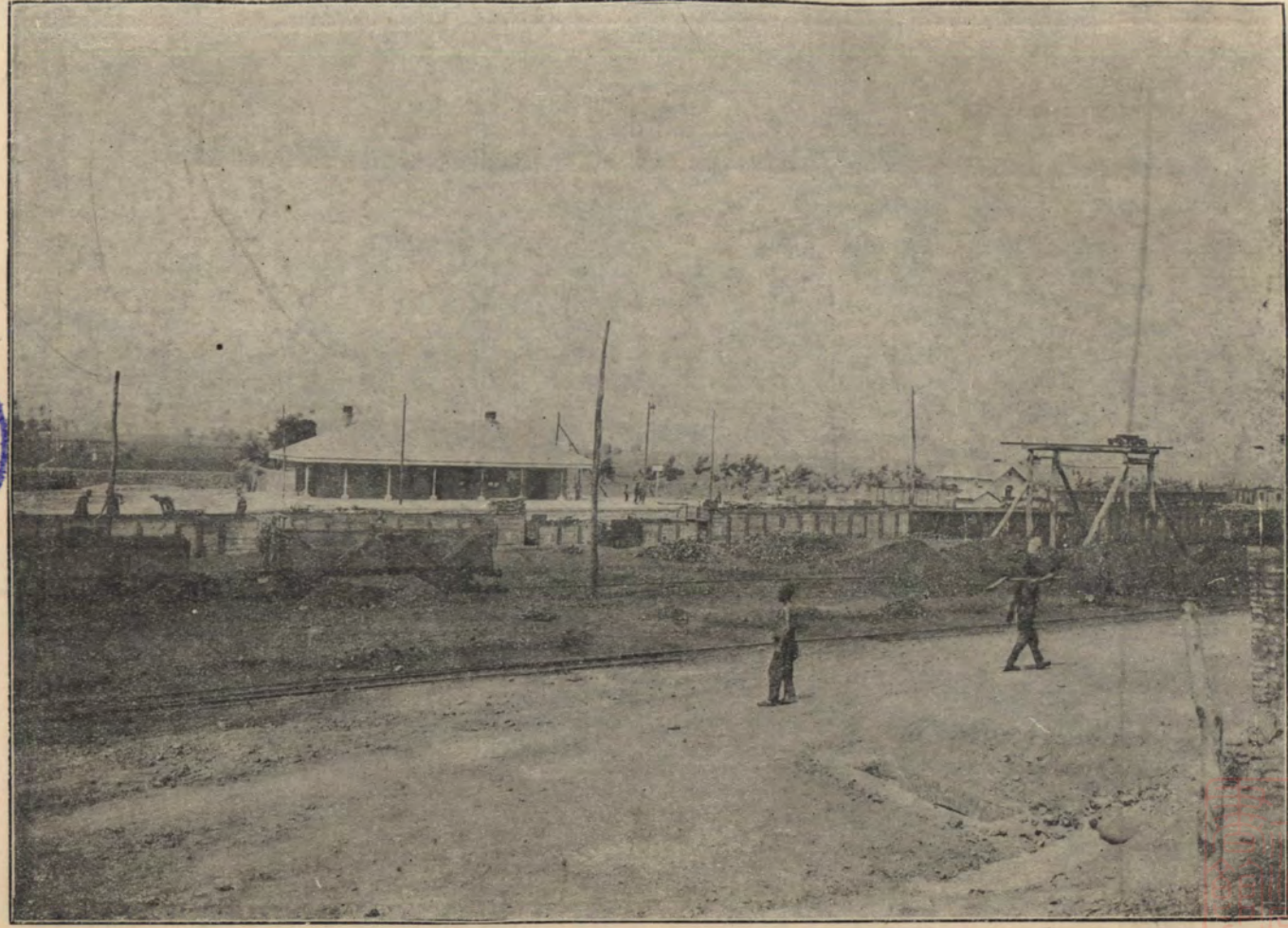
京漢鐵路支線六河溝車站
