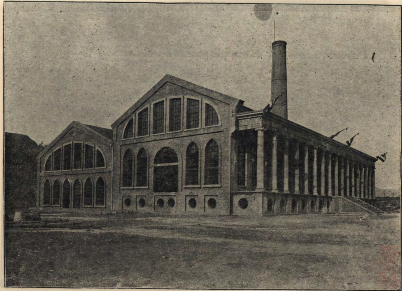
六 河 溝 煤 礦 電 廠
