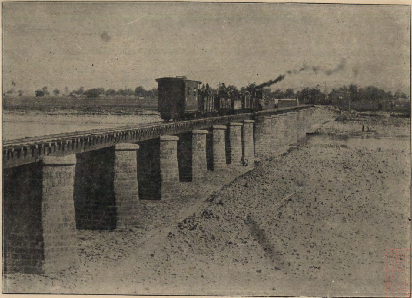
六河溝至台寨間小鐵道之漳河橋
