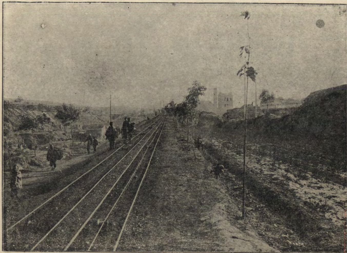
自六河溝煤礦和順井至六河溝車站斜坡運煤道
