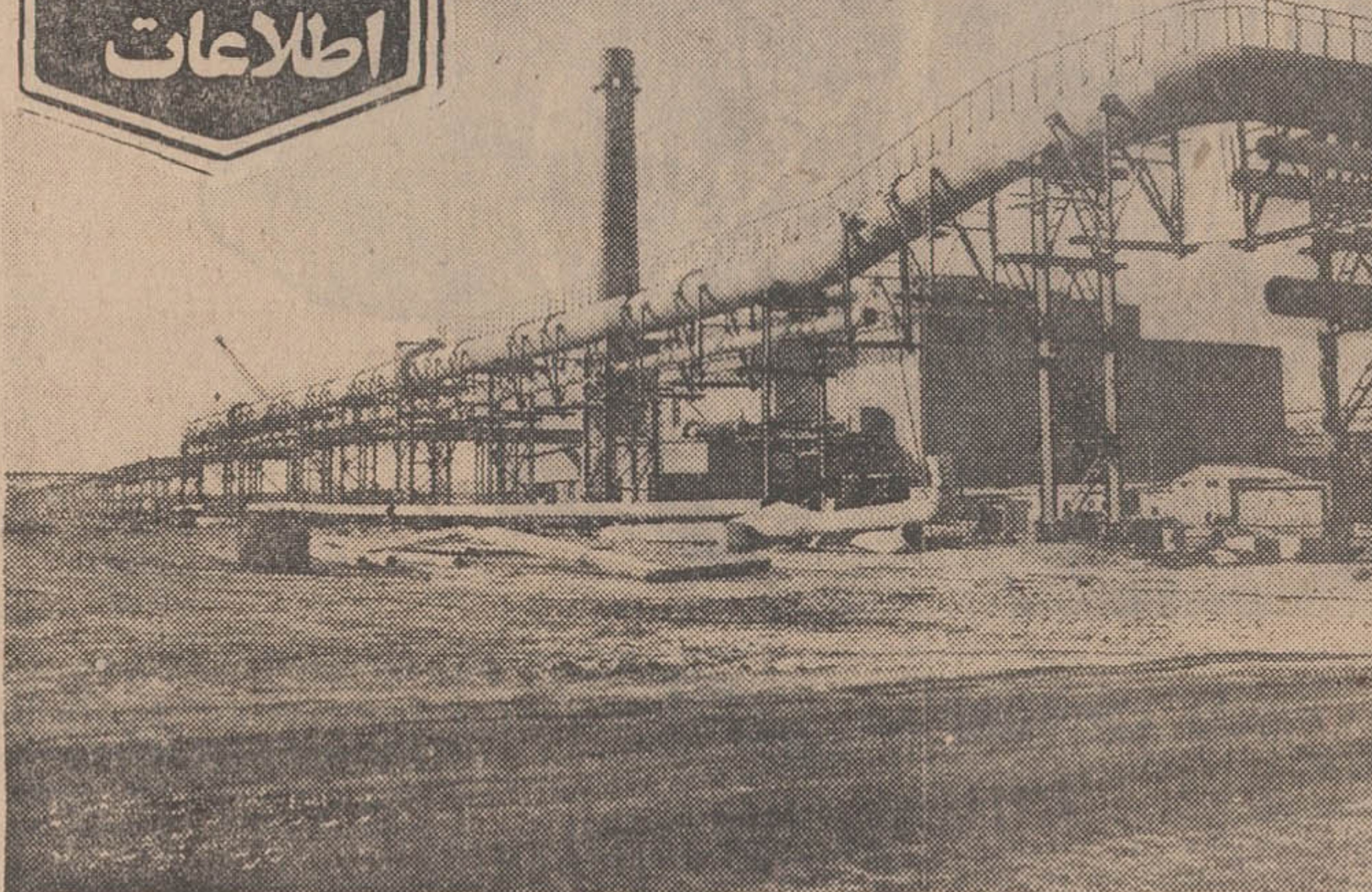
مسیر لوله‌های هوایی آب و گاز از کوره بلند به نیروگاه ذوب آهن آریامهر.
