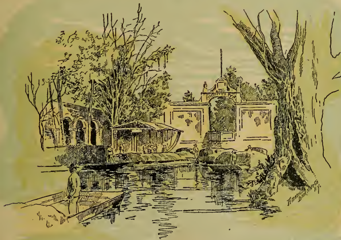
LA VIGA GATE.
