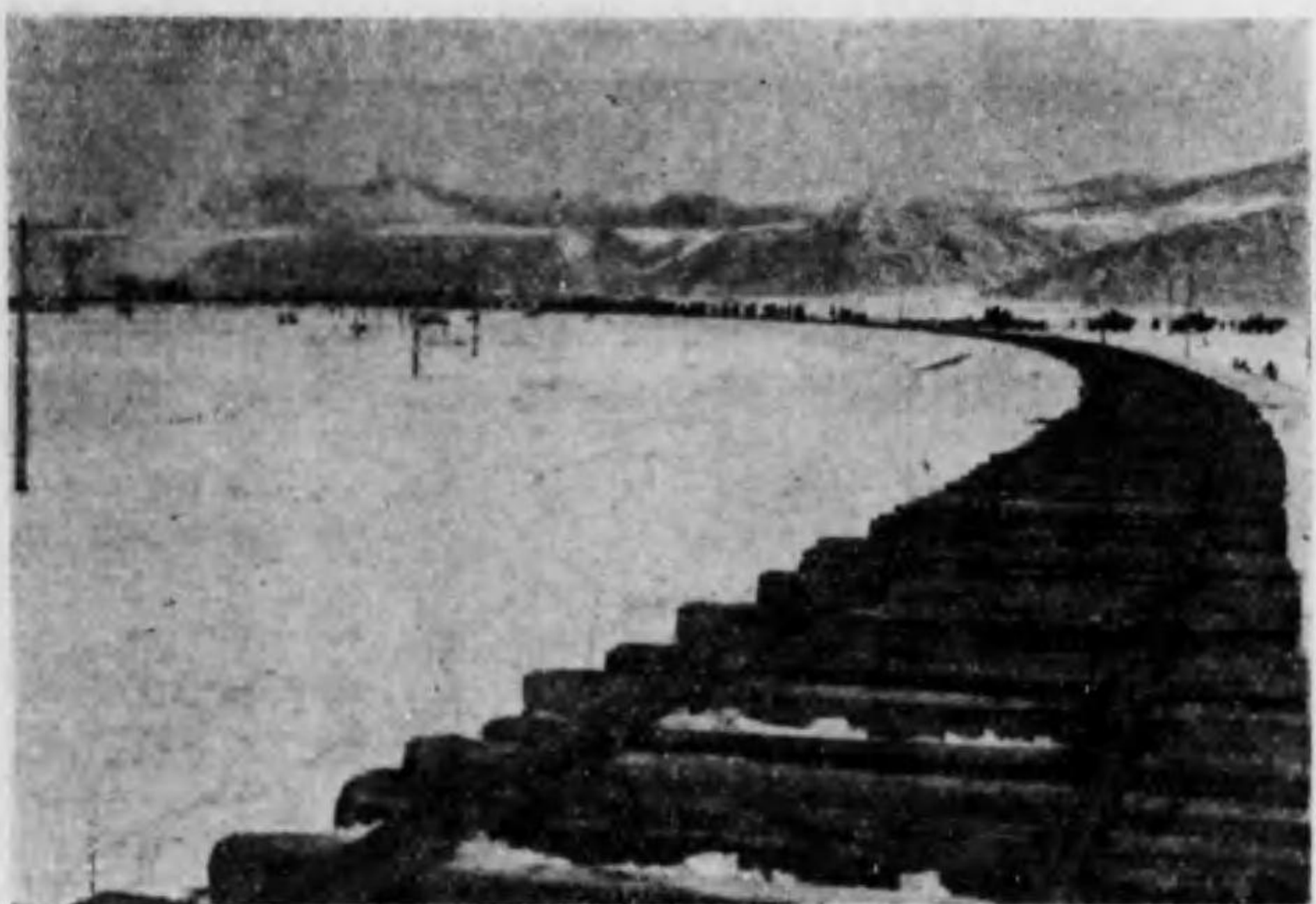
北國の鐵道建設
